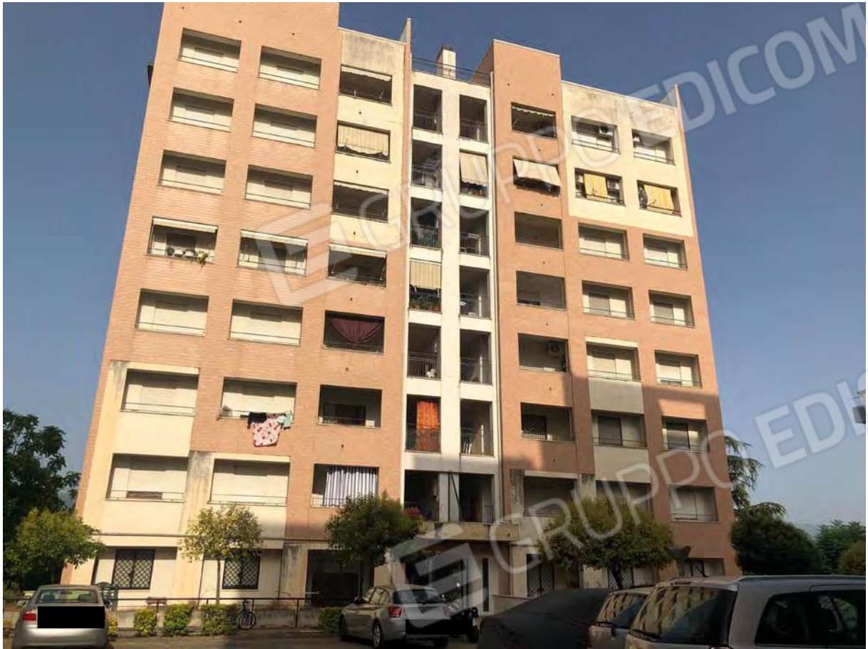
Foto 1 - Fabbricato in Rende (CS), Via Verdi.
