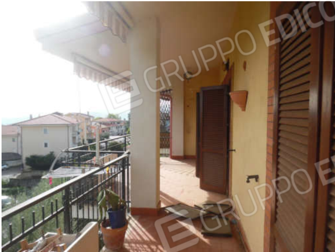
Foto 7: Piano primo – Terrazzo coperto
