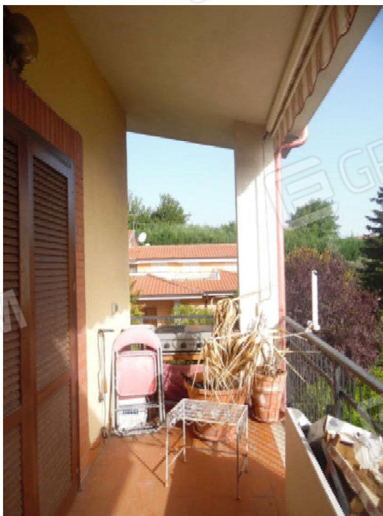
Foto 6: Piano primo – Terrazzo coperto
