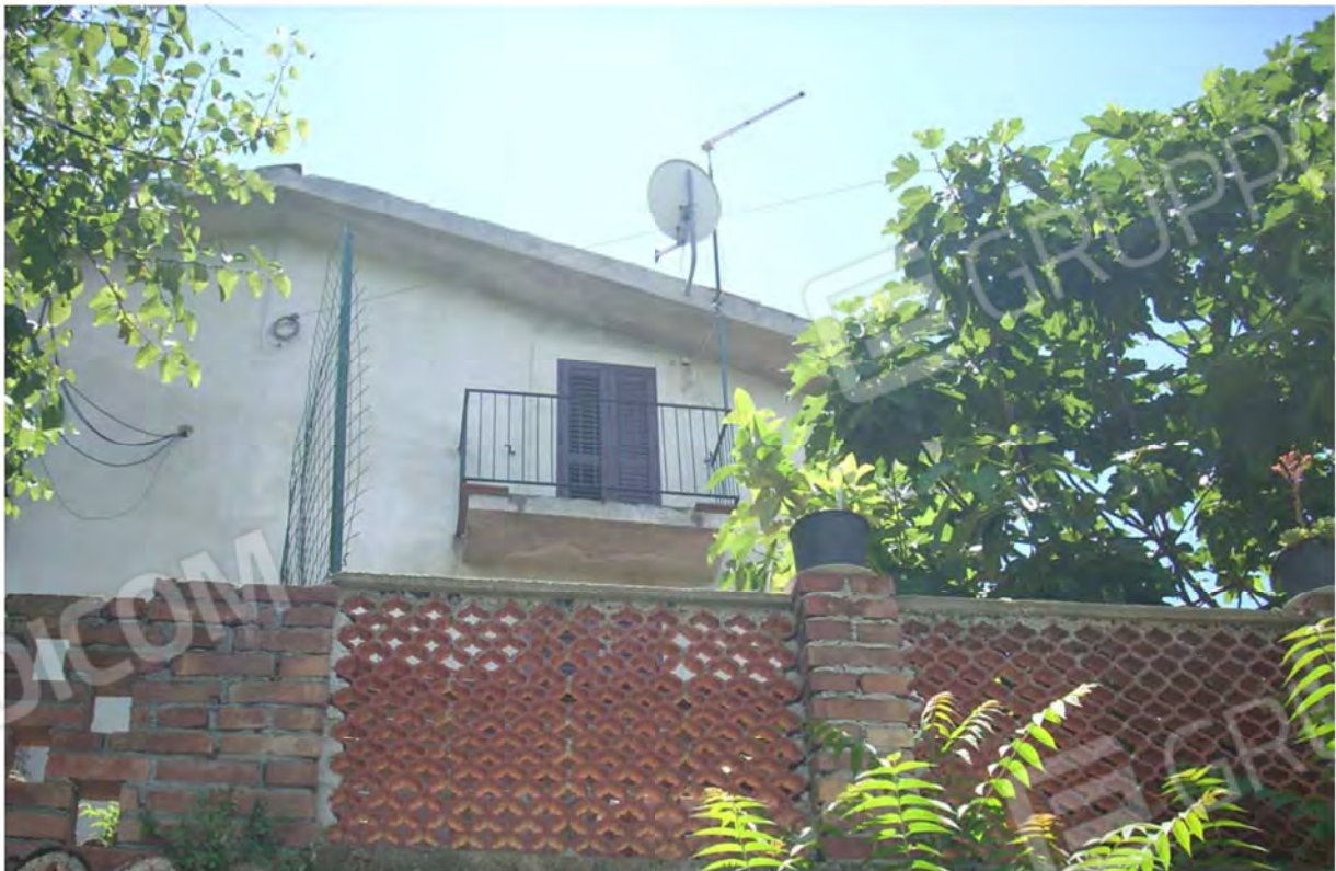
L'immobile visto dalla strada comunale sottostante.
