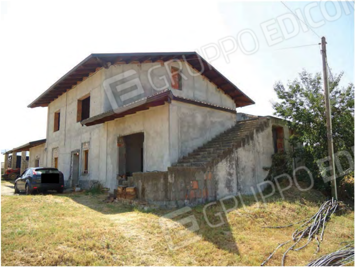
Fabbricato oggetto della perizia – Vista lato Ovest
