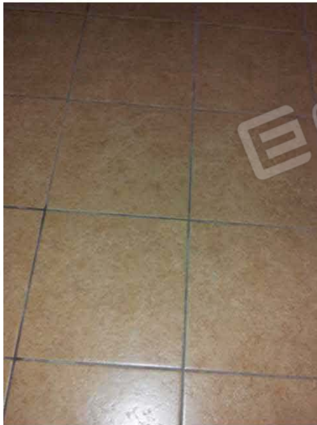
Foto 26 – Unità immobiliare sita in Scigliano alla frazione Serra di Calvisi: particolare pavimentazione zona giorno.
