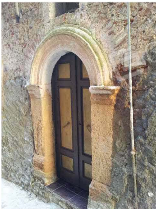
Foto 32 – Unità immobiliare in traversa di via Padolisi n. 13 censita al foglio 22 part.Ila 946 sub. 8 non facente parte dell'esecuzione immobiliare
