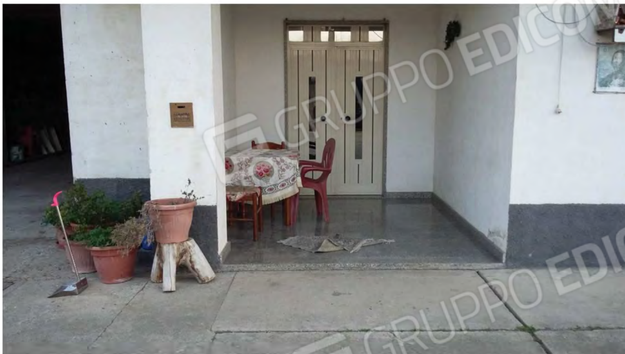
Foto 11 Esterno Corte livello seminterrato: ingresso condominiale
