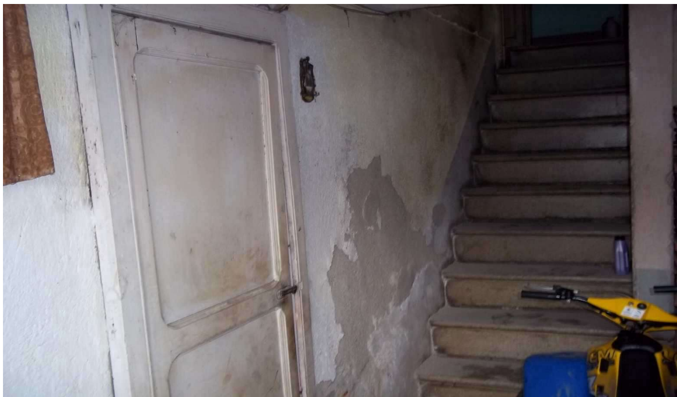
Foto n° 3 vano scala Fabbricato - lotto 1 -
