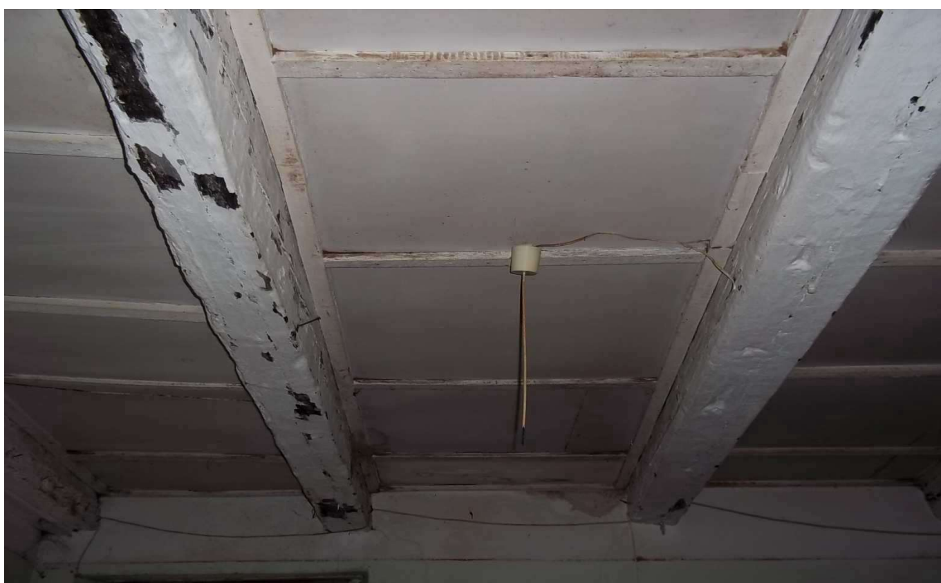
Foto n° 4 solaio fabbricato - lotto 1 -
