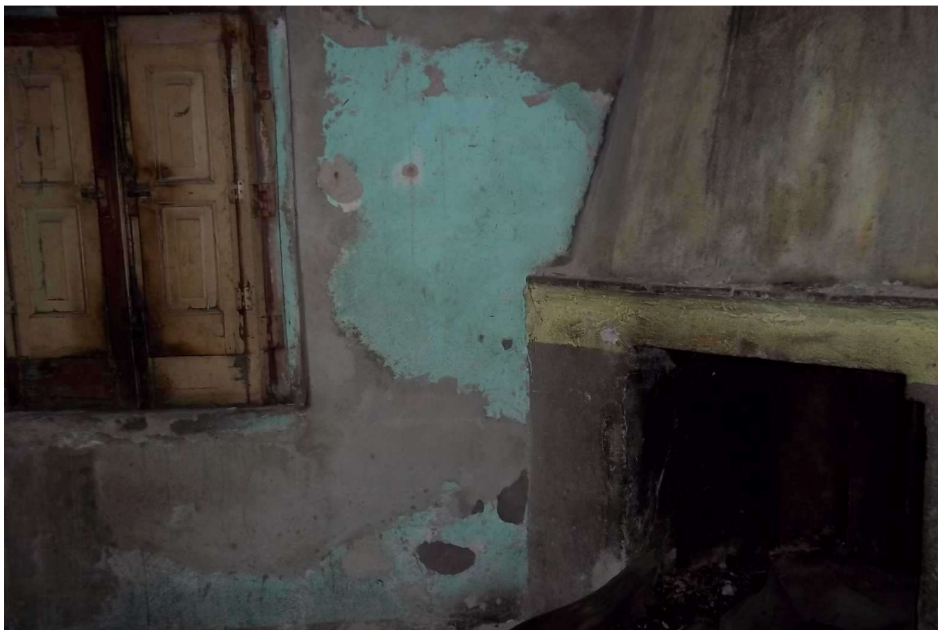
Foto n° 5 particolare infisso interno e camino fabbricato - lotto 1 –
