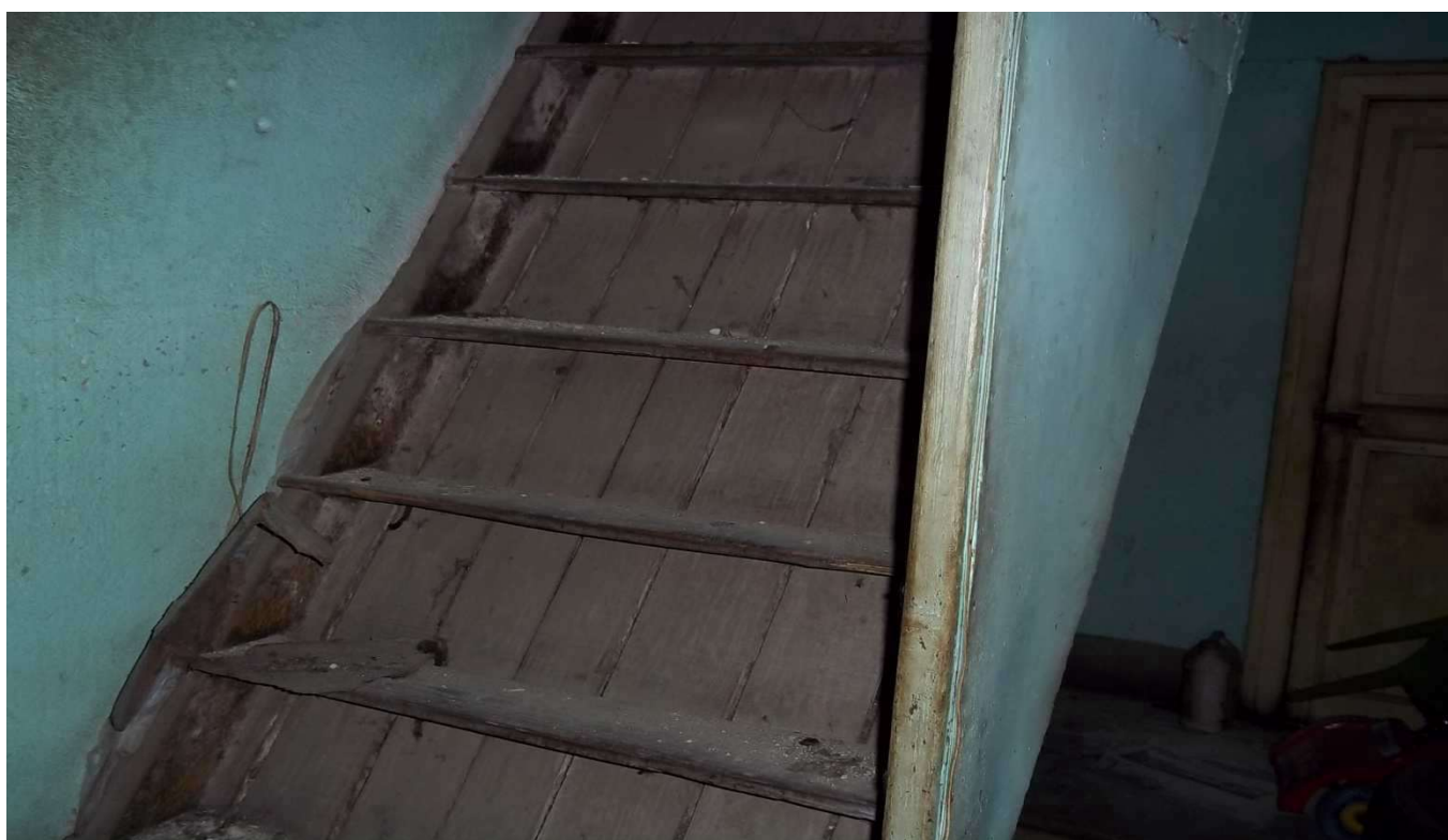
Foto n° 6 particolare scala in legno fabbricato - lotto 1 –
