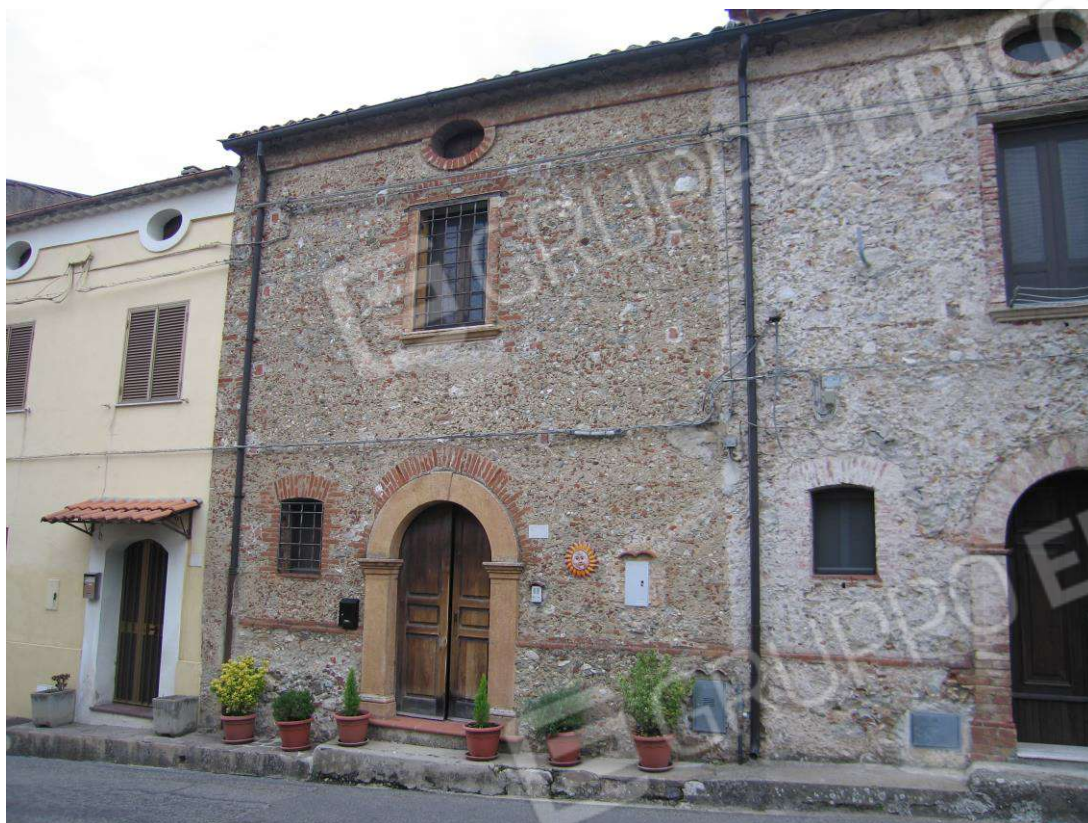
Foto n° 1 e 2 - Vista esterna da Via Ex Provinciale
