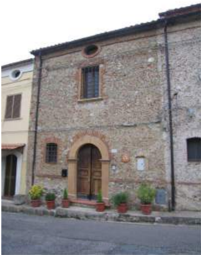
Foto n° 3 - Vista esterna da Via Ex Provinciale
