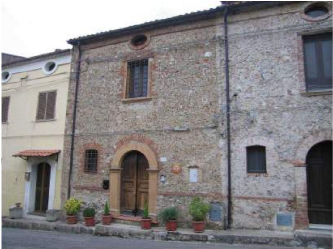
Foto n° 1 e 2 - Vista esterna da Via Ex Provinciale
