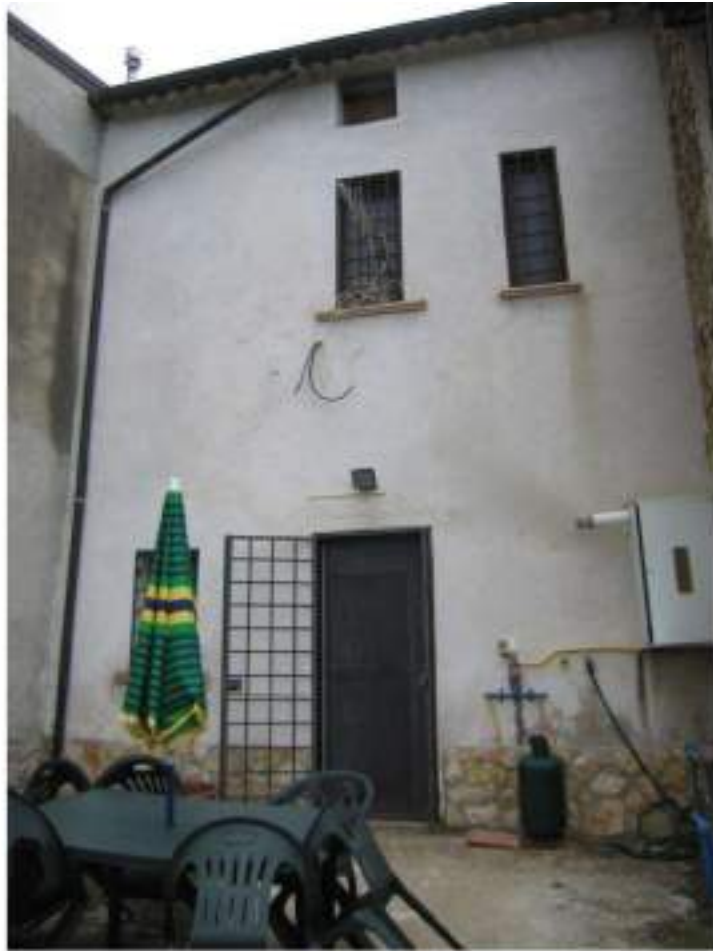
Foto n° 19 - Vista esterna lato nord-est
