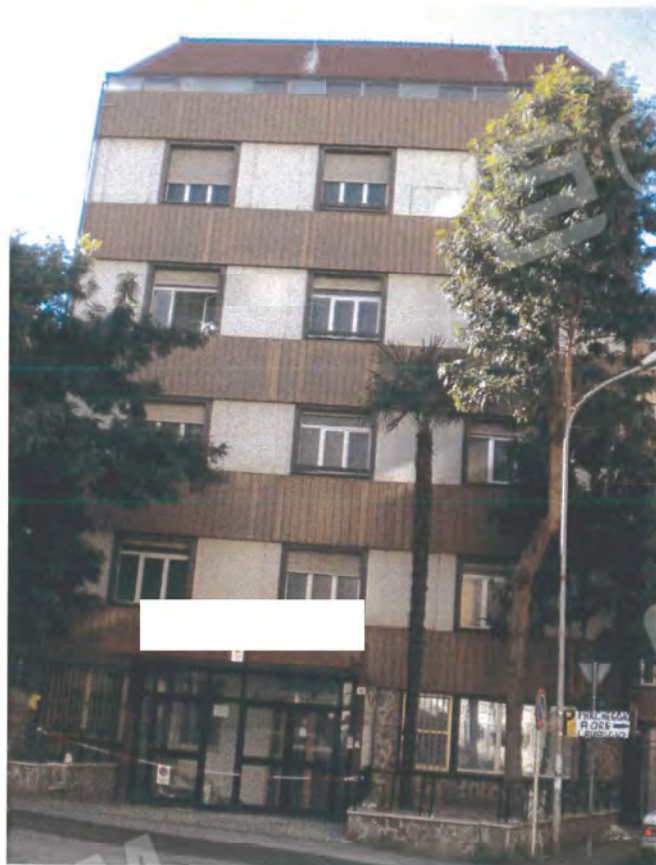
Foto 2: prospetto principale ed ingresso;
