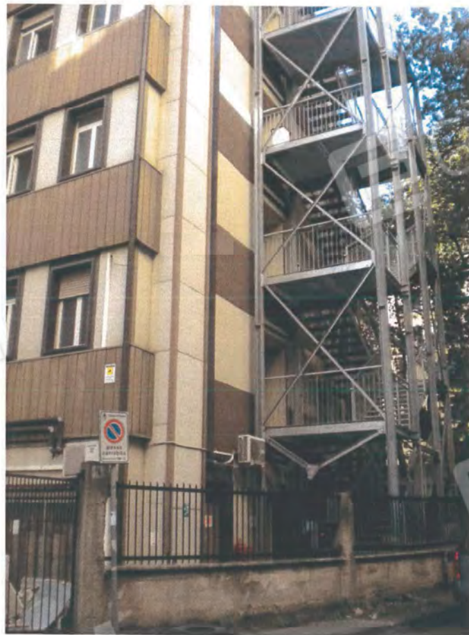
Foto 4: prospetto nord – scala d'emergenza esterna;
