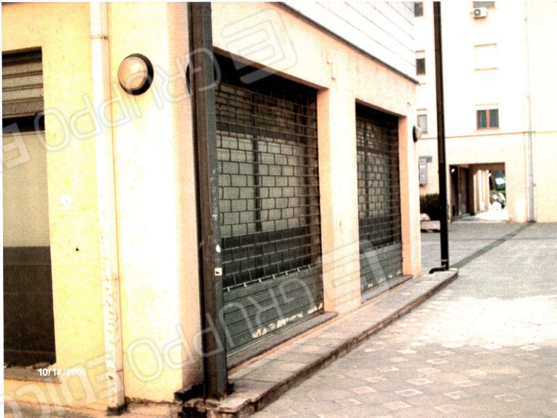
Foglio 39 p.lla 165 sub 7 porte di accesso a Nord con corte interna
