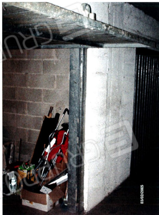
Foglio 39 p.la 165 sub 201 esterno
