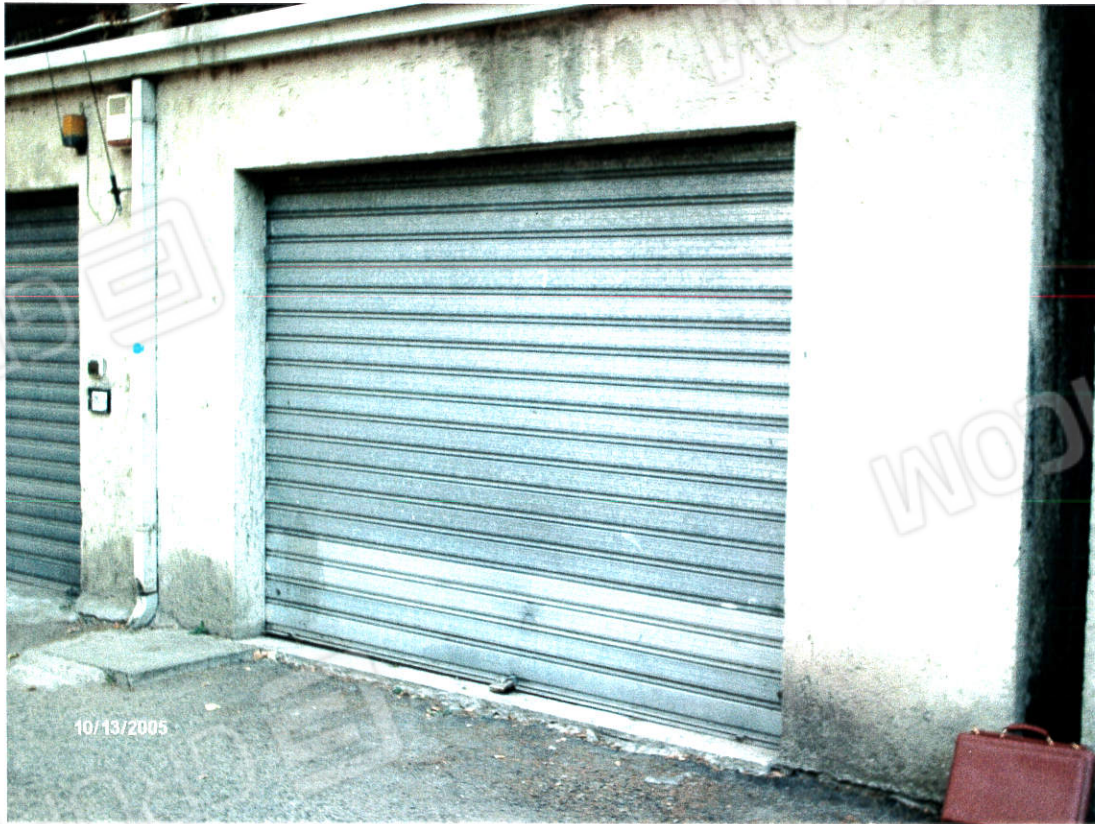
Foglio 39 p.la 165 sub 276 esterno
