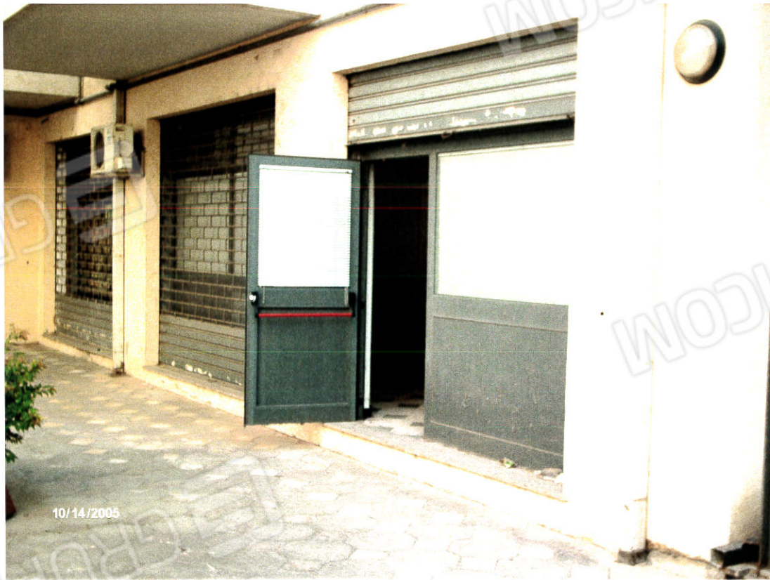
Foglio 39 p.lla 165 sub 7 porte di accesso a Est con corte interna
