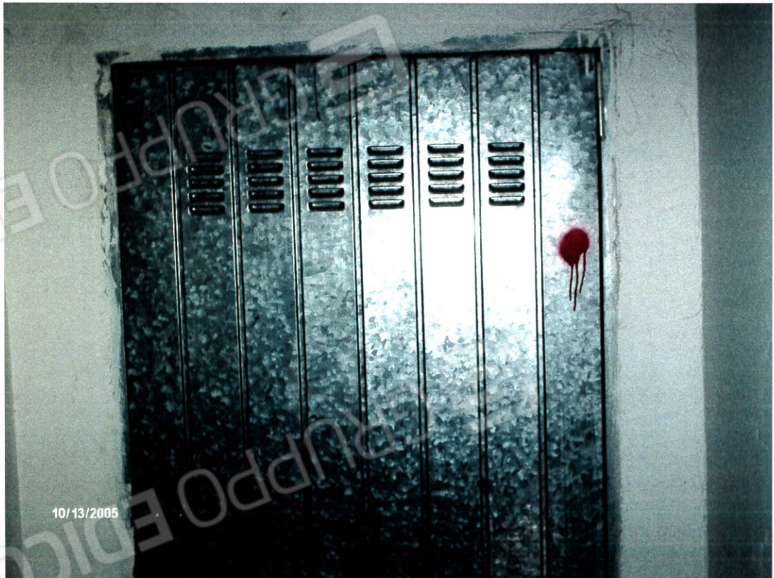
Foglio 39 p.lla 165 sub 105 porta zincata di accesso
