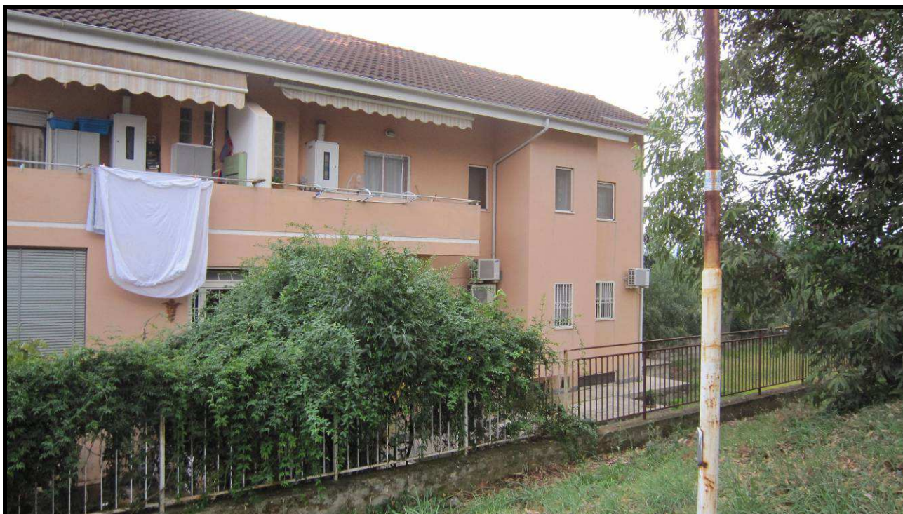
Foto 2 Fabbricato part. 755 in vista da Nord-Ovest
