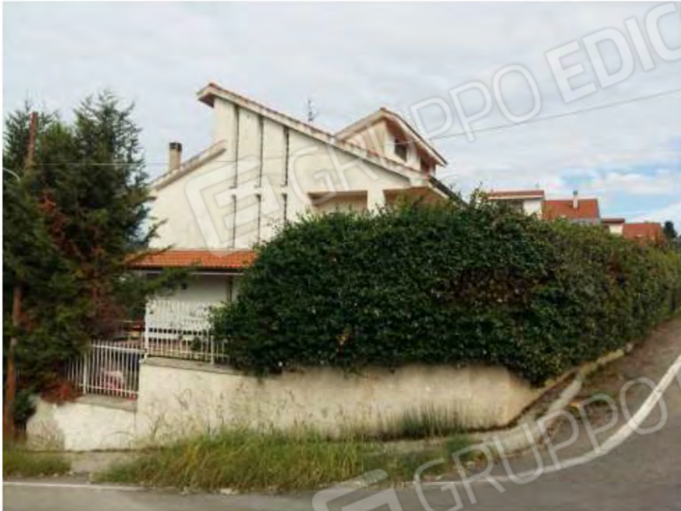
Villa bifamiliare (fabbricato interessato) - lato Sud
