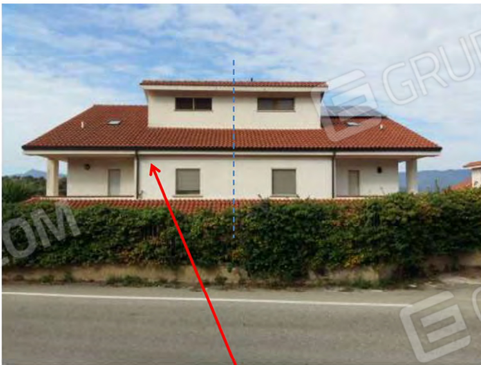
Villa bifamiliare (fabbricato interessato porzione di sinistra) – lato Est
