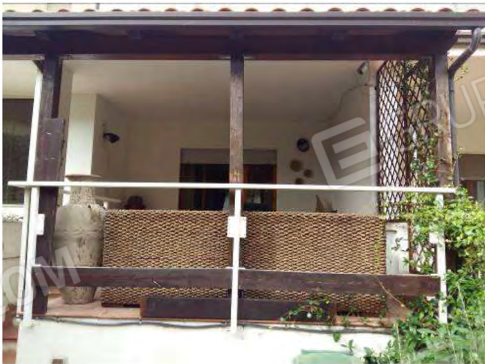
Veranda vista da giardino
