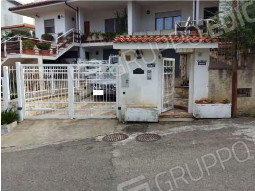
Ingresso carrabile e pedonale
