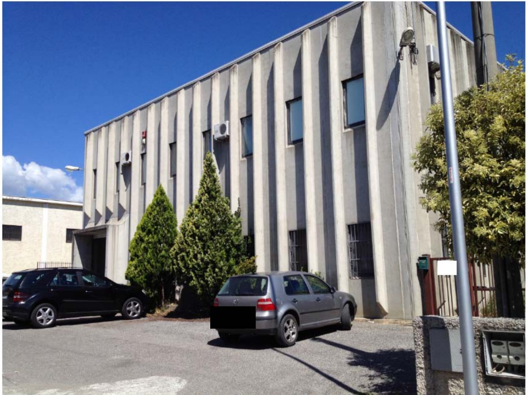
(Foto 1 – Vista capannone dal lato Est)
