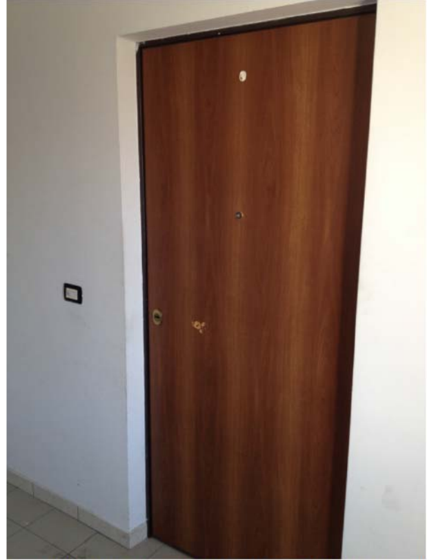
(Foto 20 – Ingresso appartamento 1 al primo piano)
