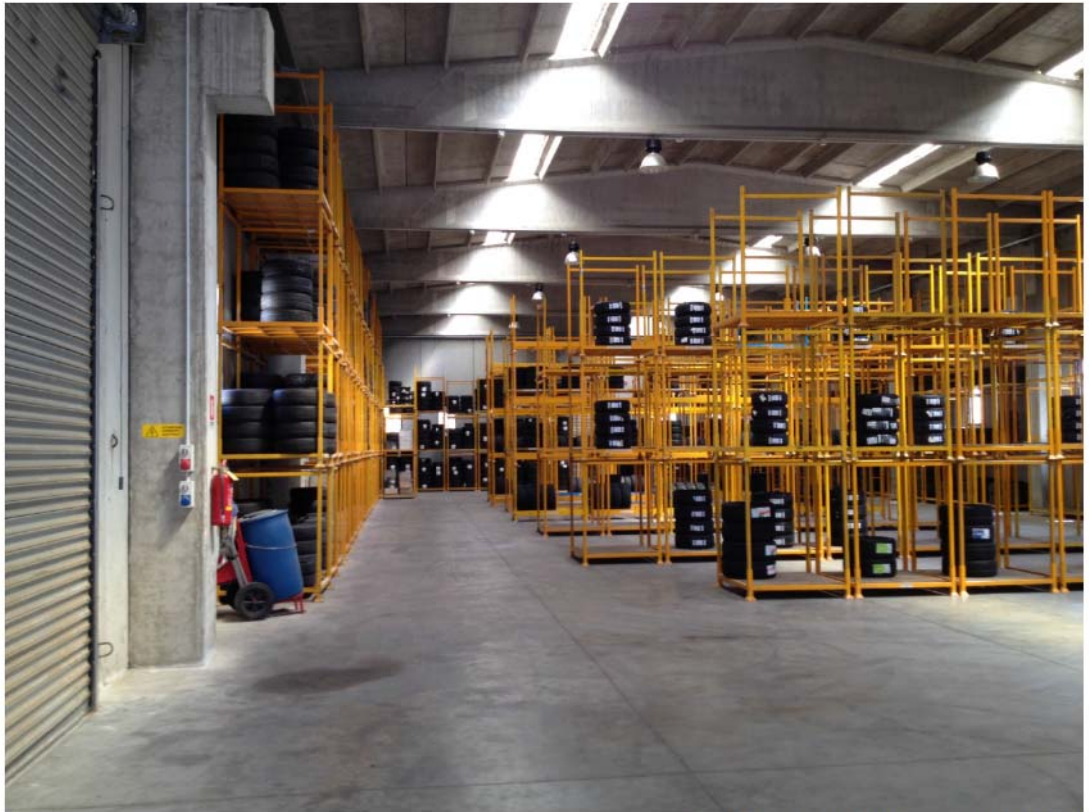
(Foto 5 – Vista interno capannone)
