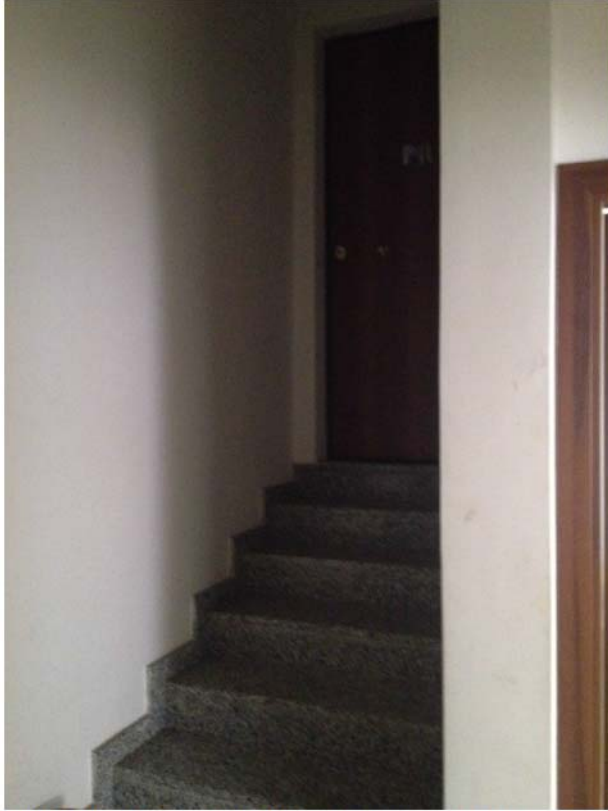
(Foto 19 – vano scala interno al piano terra)
