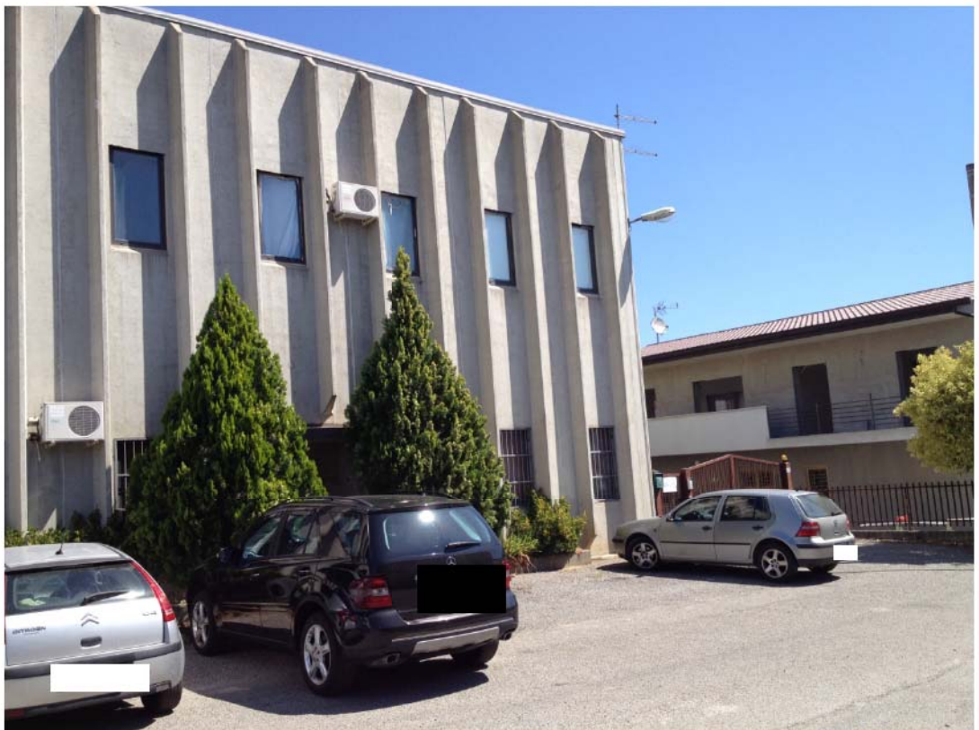
(Foto 2 – Vista capannone dal lato Ovest)
