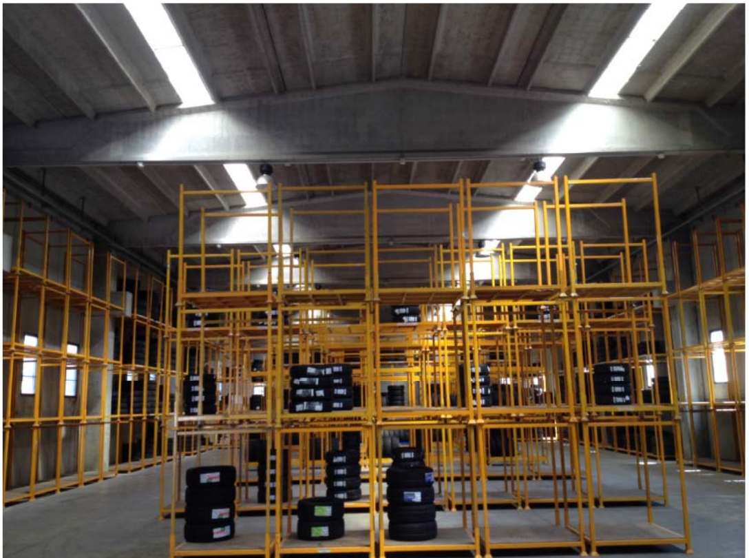
(Foto 8 – Vista interno capannone)
