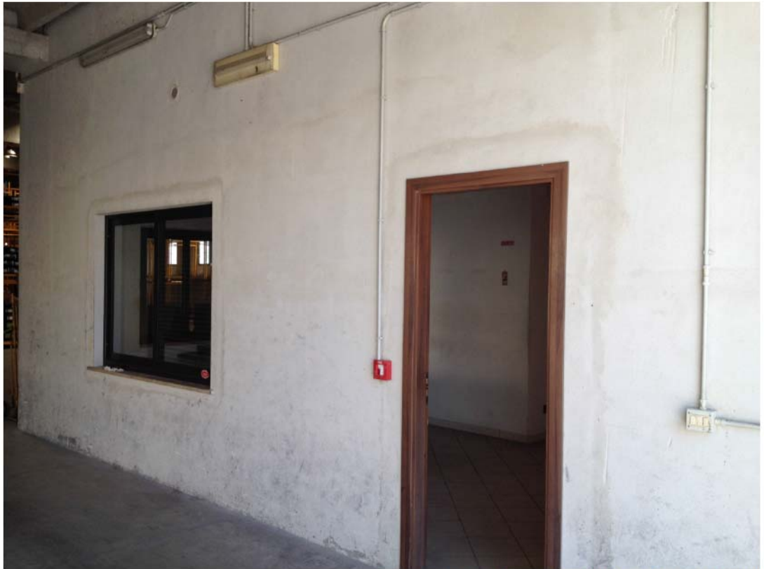
(Foto 11 – accesso uffici al piano terra)
