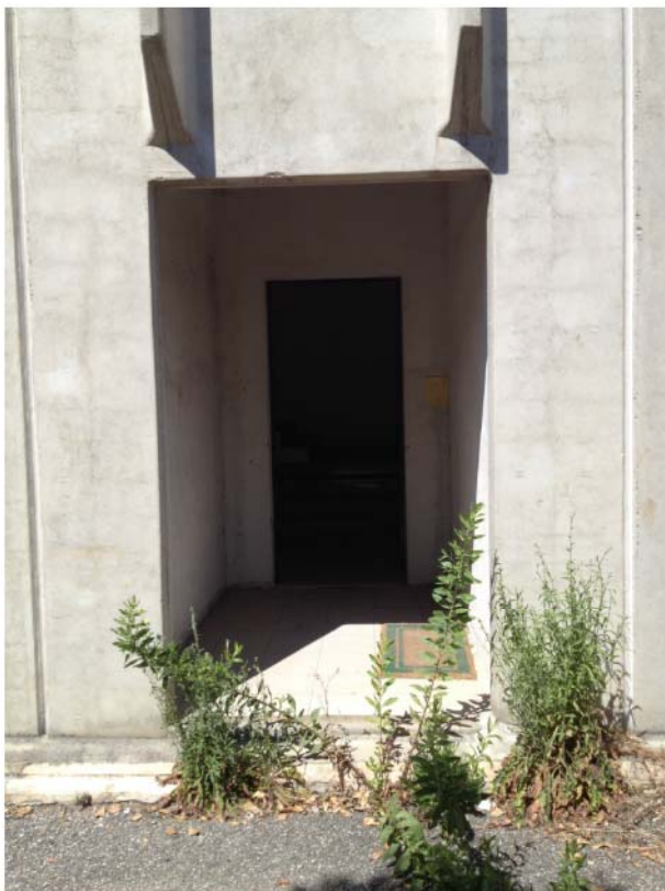
(Foto 28 – accesso vano scala dall'esterno)
