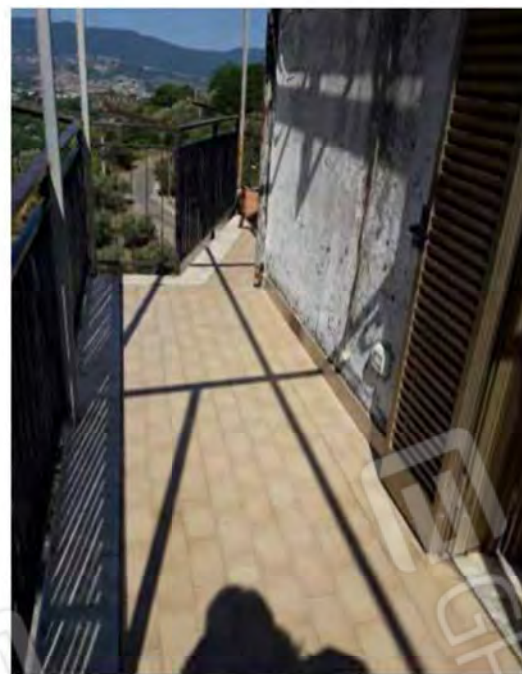
LOTTO 1: Piano sottotetto -balcone
