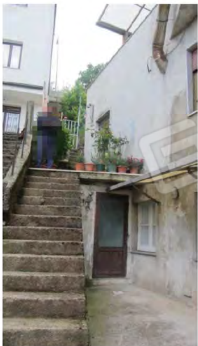
Seconda rampa di accesso scala esterna
