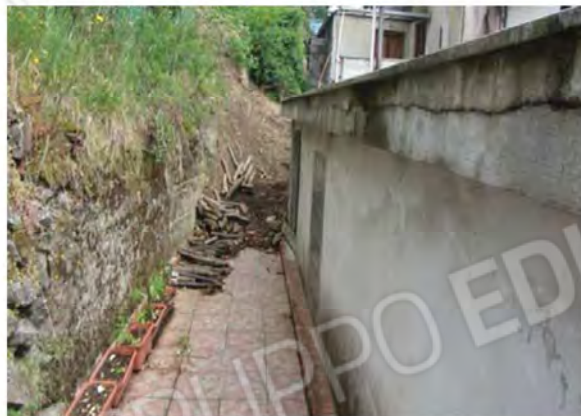
Percorso pavimentato di accesso
