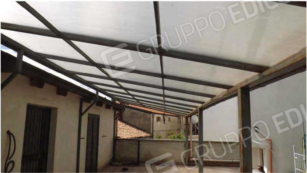
Particolare della tettoia in ferro con pannelli di alveolater
