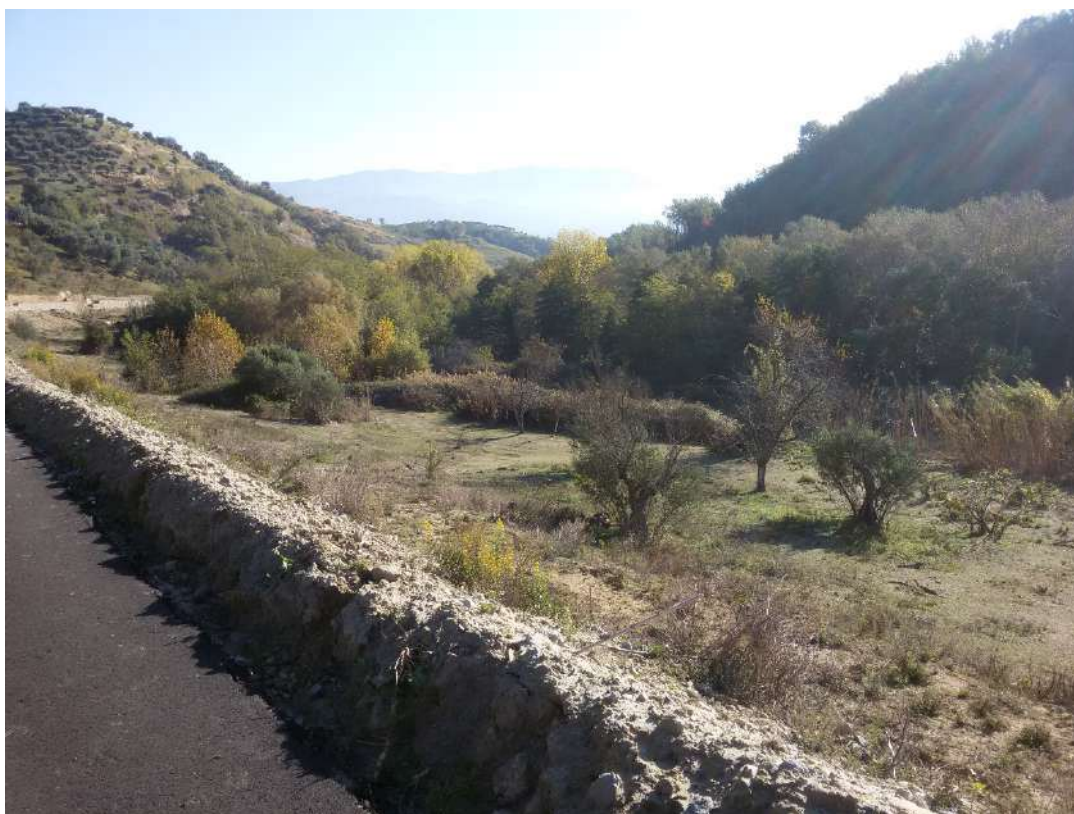
FOTO 3 – Confine terreni con strada comunale in fase di realizzazione.
