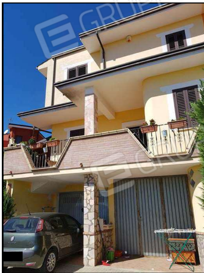
Figura 4 - Accesso principale al seminterrato. Foglio 43, particella 295, sub.5
