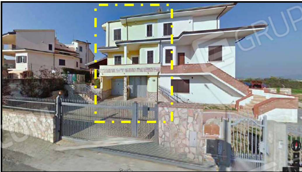
Figura 3 – Prospetto fabbricato con individuazione degli immobili pignorati.
