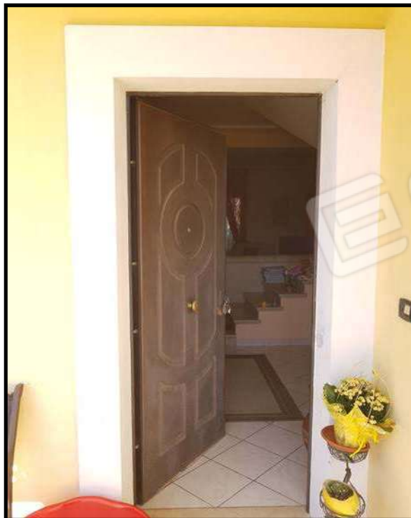
Figura 9 – Portone blindato appartamento. Foglio 43, particella 295, sub.5
