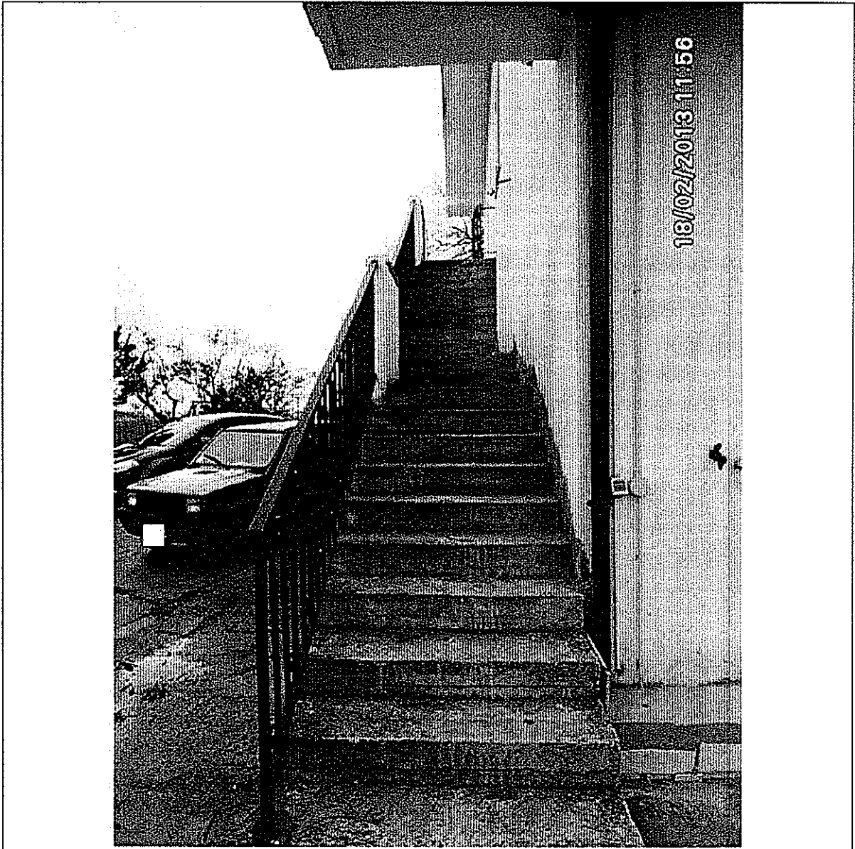
FOTO N. 5: Scala Esterna (corte esclusiva)
