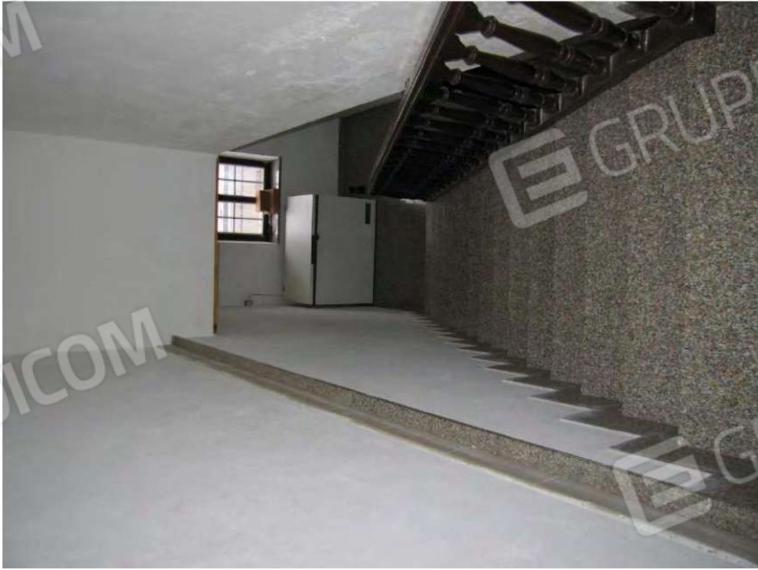
Foto n° 63 e 64 - Vano scala
