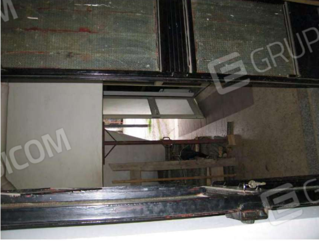
Foto n° 9 - Vano scala piano seminterrato
