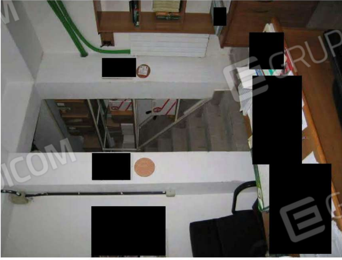
Foto n° 15 e 16 - Immobile sub 1 (piano seminterrato)
