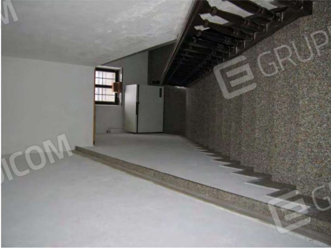
Foto n° 63 e 64 - Vano scala
