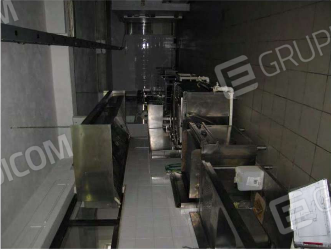
Foto n° 11 e 12 - Immobile sub 1 (piano seminterrato)
