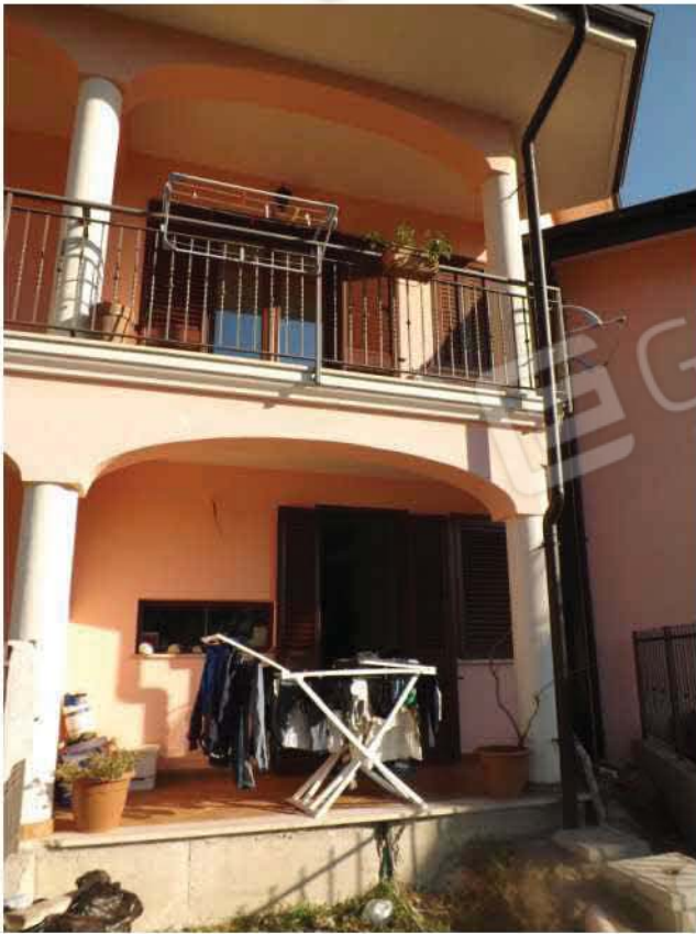
IL PORTICO E IL BALCONE SUL PROSPETTO EST
