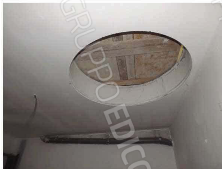
PARTICOLARE TAGLIO PER VANO SCALA
