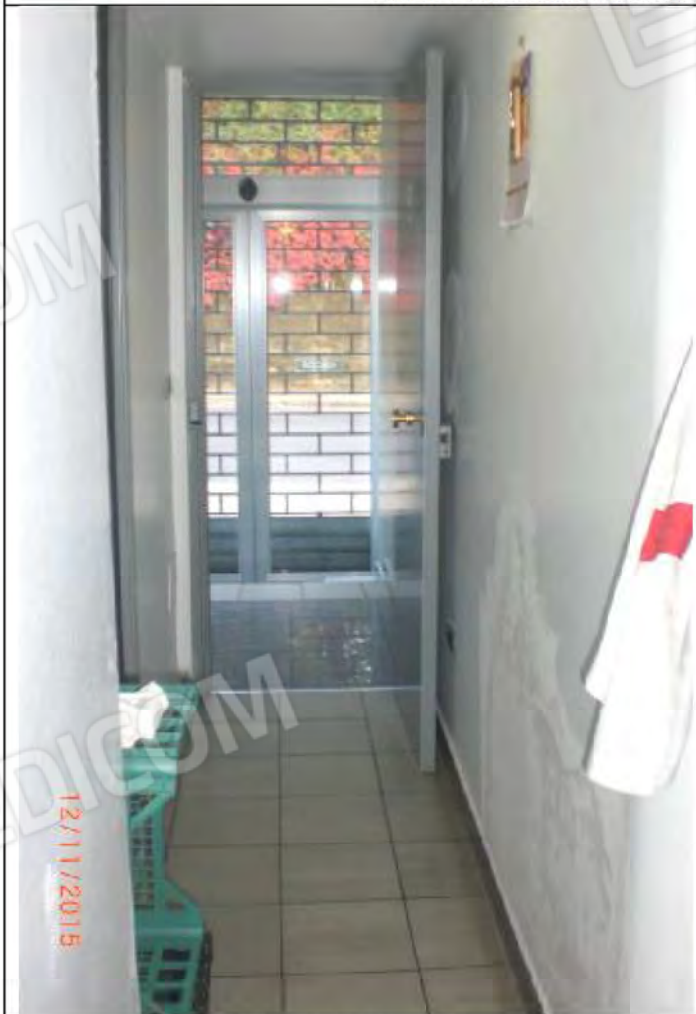
Foto n. 3: Corridoio interno a piano terra
