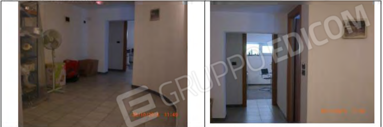
Foto n. 22 e n. 23: Spazi di distribuzione interna al piano soppalcato
