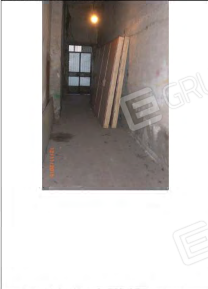
Foto n. 15: Corridoio condominiale al piano seminterrato
