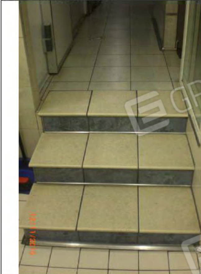
Foto n. 5: Gradini interni per superare dislivello tra zone a piano terra
