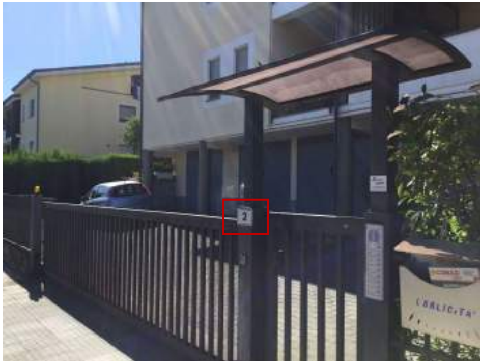
Vista fabbricato con indicazioni toponomastiche - civico n. 2 di via Coppi
