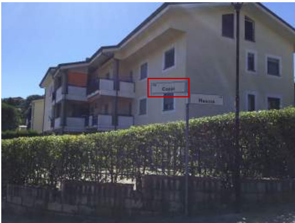
Vista fabbricato con indicazioni toponomastiche - via Coppi
