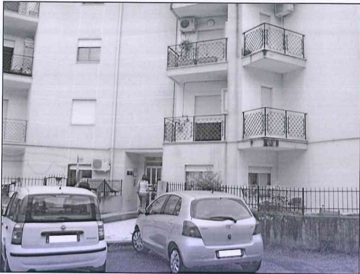
Foto 1 – Vista esterna del fabbricato sito in Montalto Uffugo (CS)
