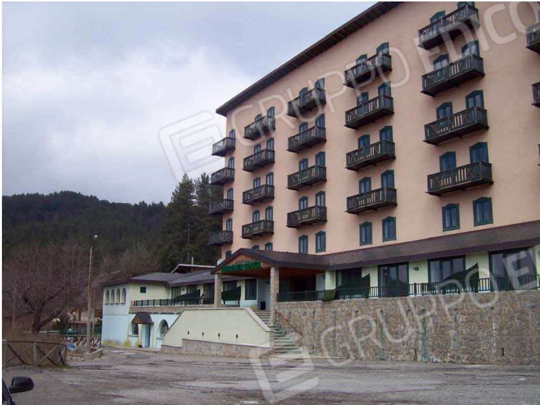
Foto 1 – Ingresso alla struttura
