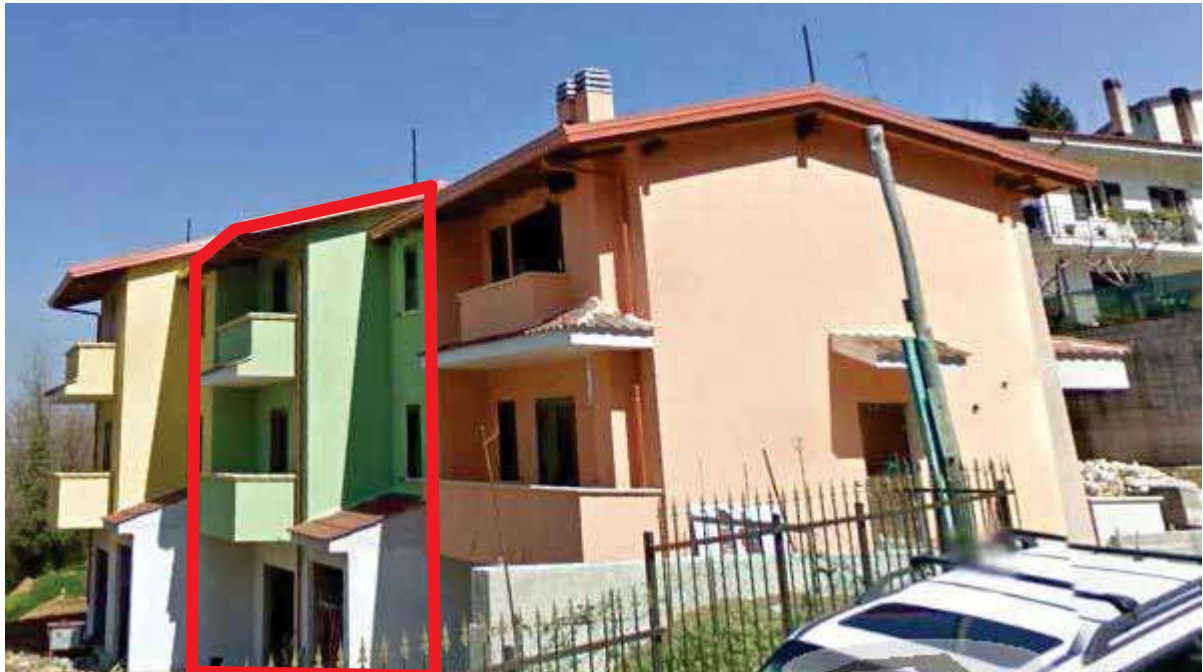
Figura 3: Stabile di cui fa parte l'immobile pignorato- vista lato sud-est.
