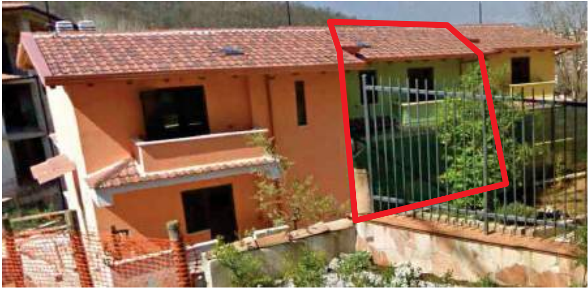
Figura 2: Stabile di cui fa parte l'immobile pignorato- vista lato nord.
