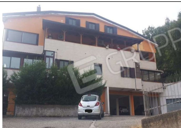
4 -Foto prospettiva della facciata principale del fabbricato Scala "A", in cui al Piano Seminterrato Primo è posta l'Unità immobiliare in oggetto.
