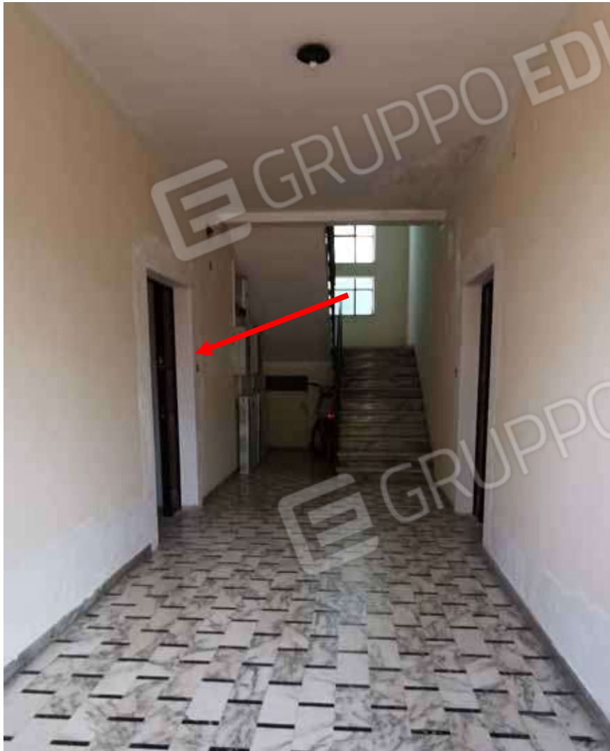
Foto 41: Lotto 9 - androne ingresso.
