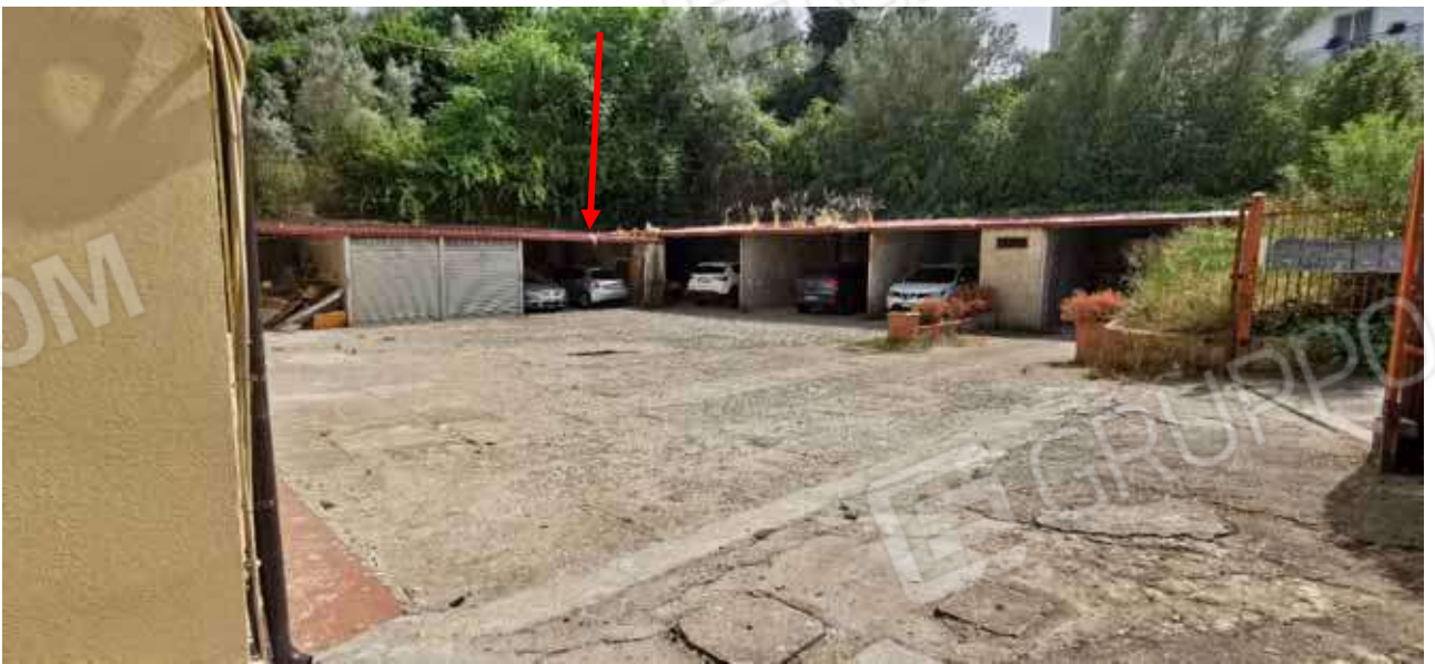
Foto 51: Lotto 11 - tettoia sub. 3
