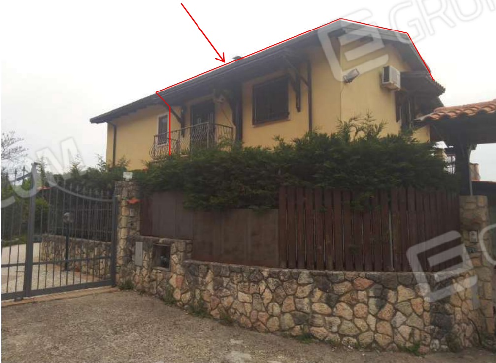
FOTO 2 – Vista SUD – OVEST
