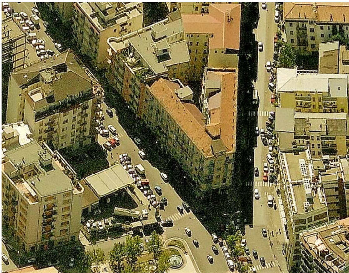
Veduta aerea da setentrione del fabbricato
