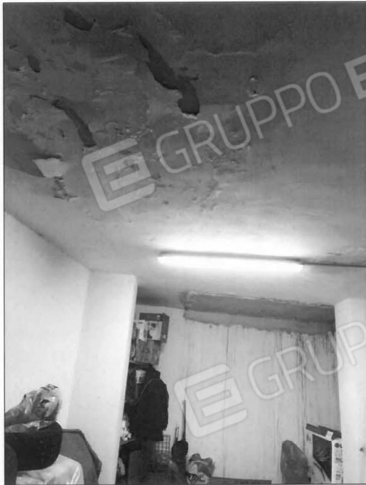
Foto n. 3: Problemi di infiltrazioni sul soffitto
