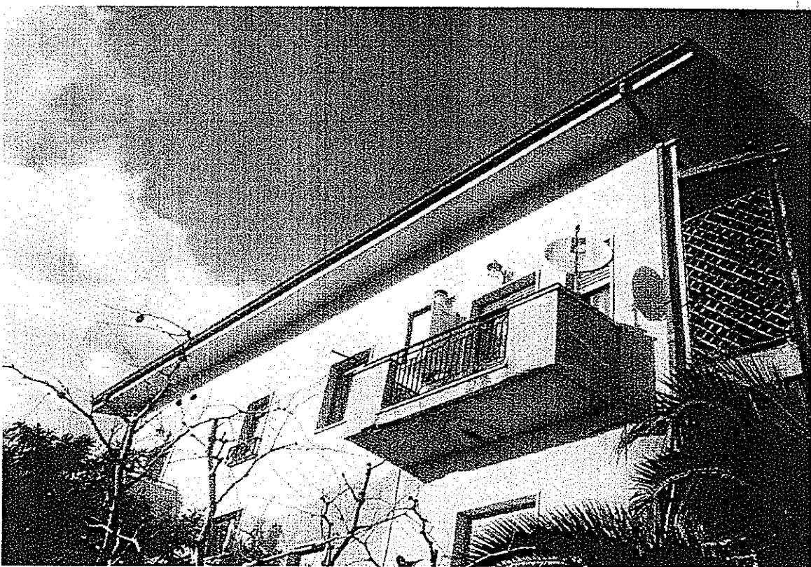
Foto n° 2: vista abitazione sita in Trenta (CS) frazione Maglie Via Campitelli n° 7 - 2° piano - Foglio 7 part. 319 sub. 3
