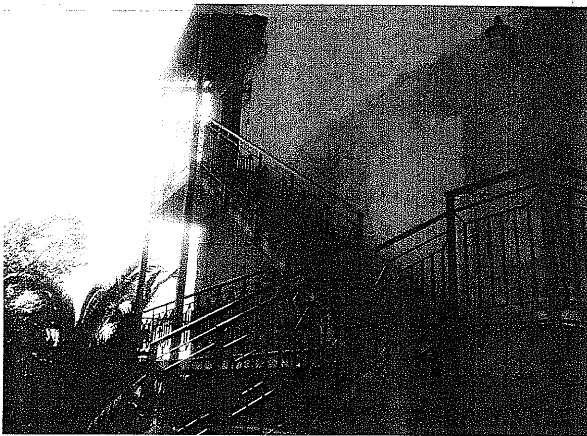
Foto n° 4: scala accesso abitazione sita in Trenta (CS) frazione Maglie Via Campitelli n° 7 - 2° piano - Foglio 7 part. 319 sub. 3
