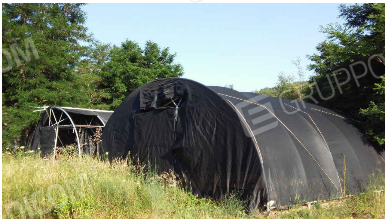
altre serre dismesse su terreni adiacenti di altre proprietà
