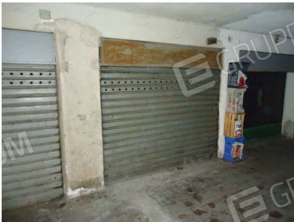
FOTO N° 12 : Seminterrato Comune di Rende - Foglio n° 50 , Part. n° 380 Sub. n° 38.
