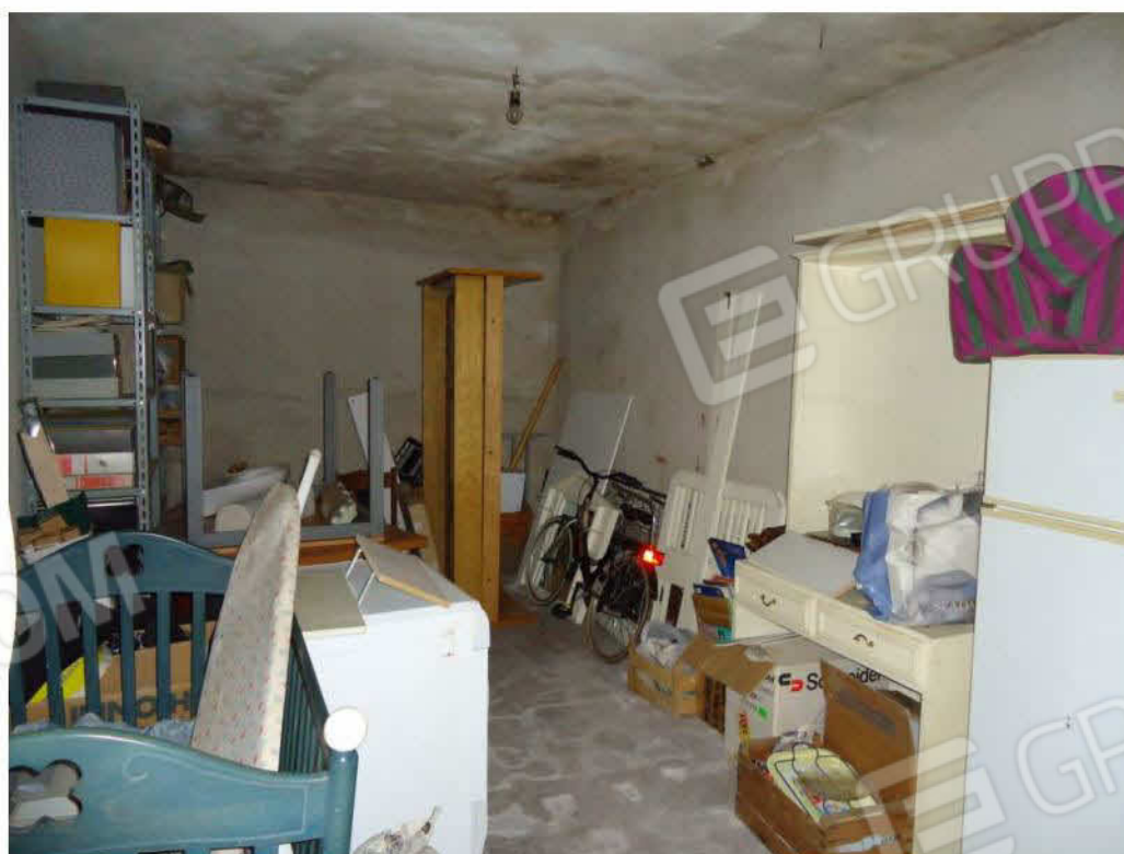
FOTO N° 14 : Seminterrato Comune di Rende - Foglio n° 50 , Part. n° 380 Sub. n° 38.
