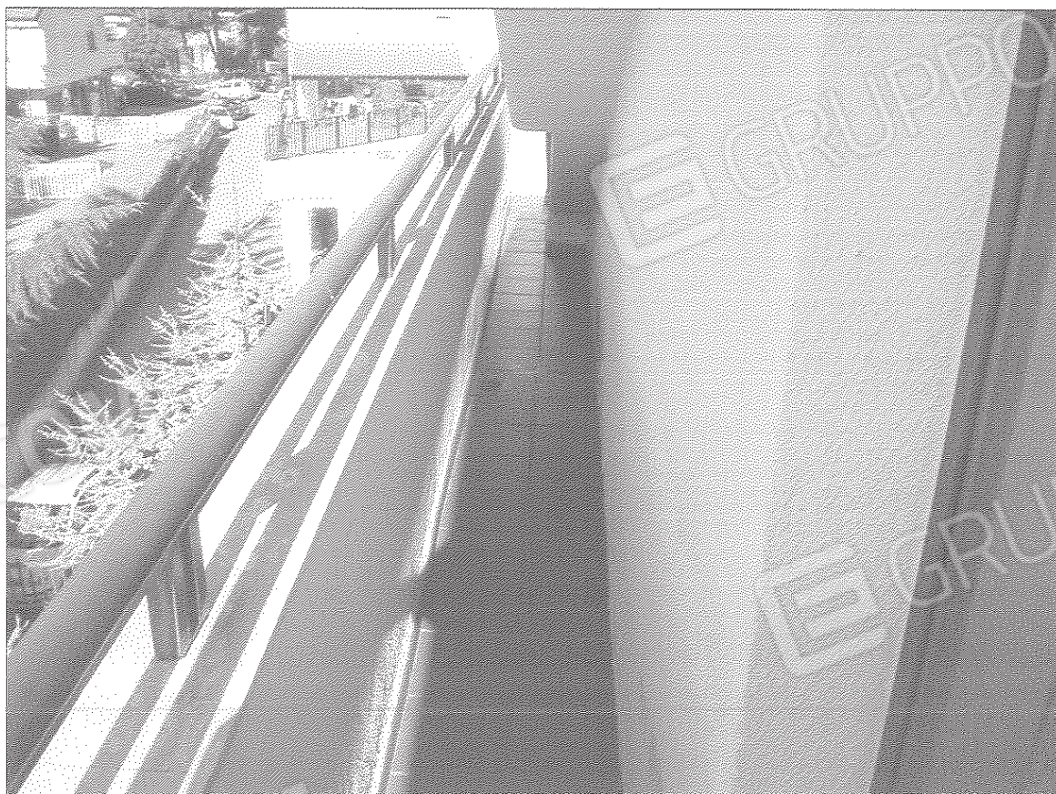
Foto N° 46 – Piano Sottotetto (Appartamento 2): Piccolo balconcino posto sul lato Ovest.
