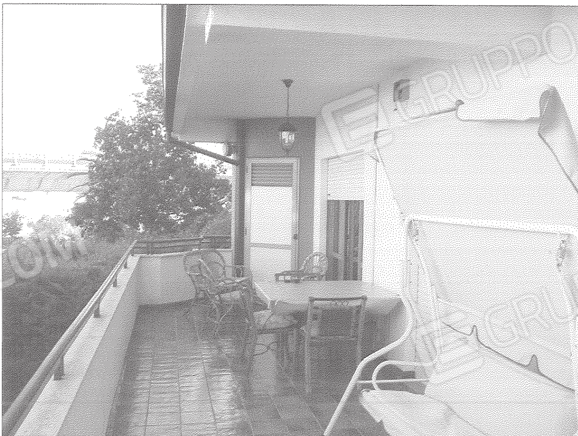
Foto N° 36 – Piano Terra (Appartamento 1): Balcone con locale caldaia.
