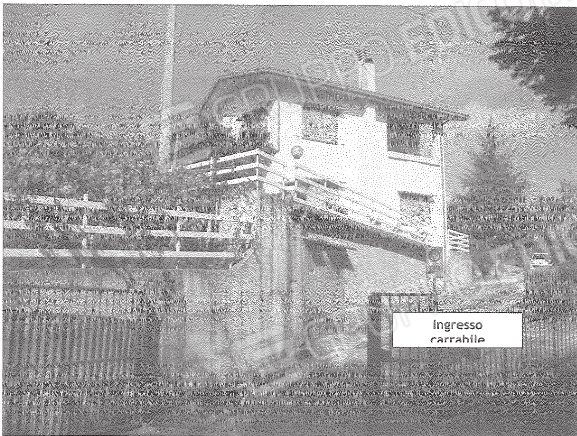
Foto N° 5 – Prospetto Est con ingresso al locale abusivo.
