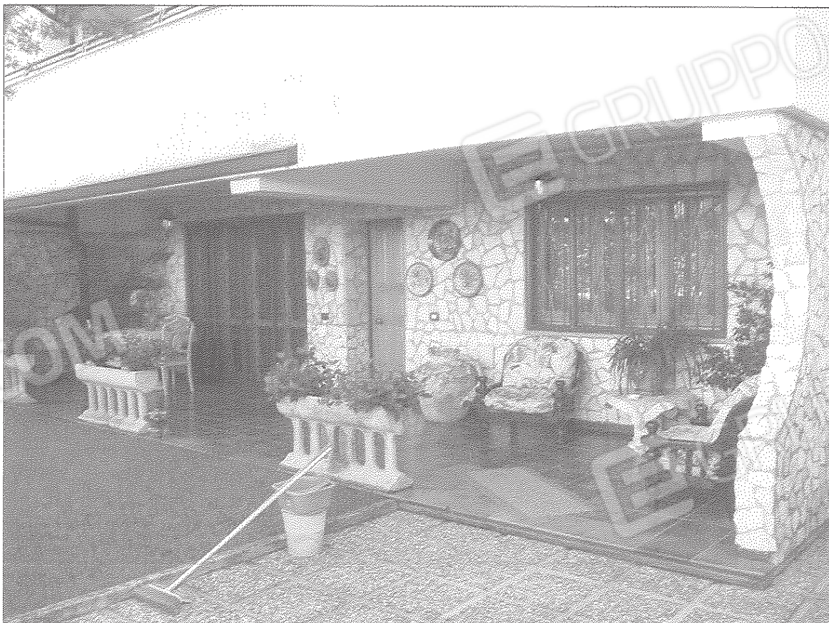
Foto N° 24 – Prospetto Nord con ingresso al Piano Seminterrato dell'Appartamento 1.
