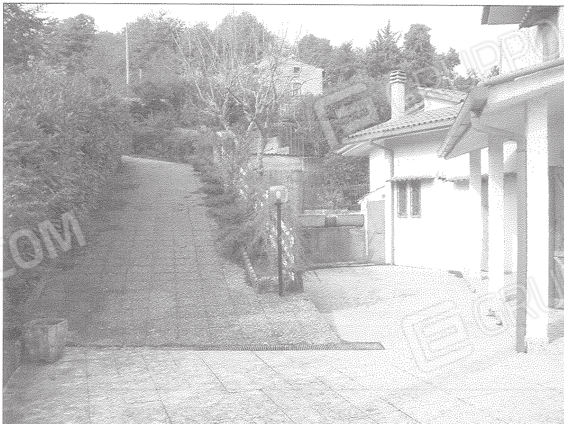
Foto N° 6 – Rampa di ingresso alla proprietà con corte esterna pavimentata.
