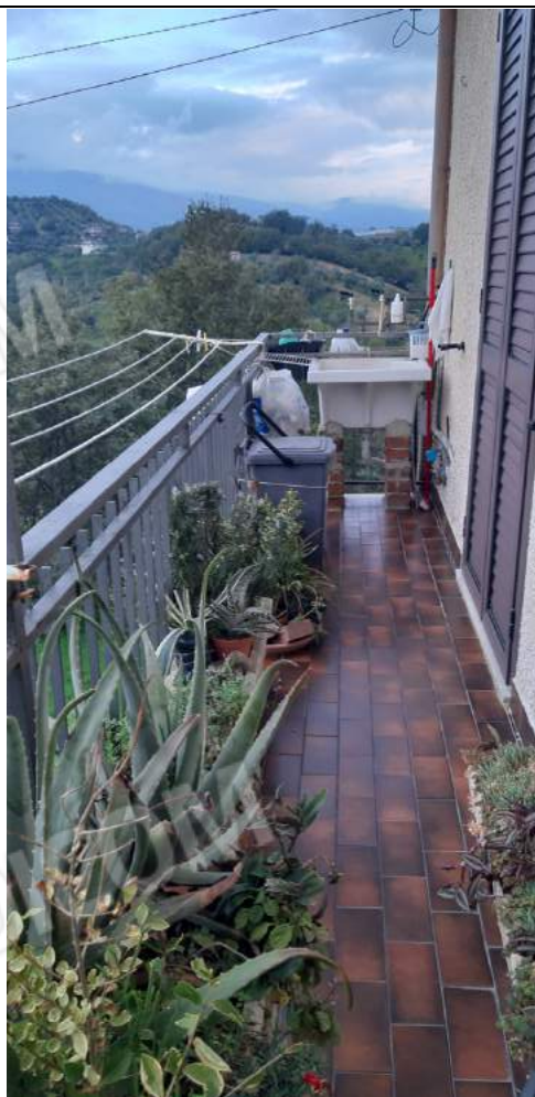
Foto n. 23 : Balcone prosecuzione del portico prospetto ovest
