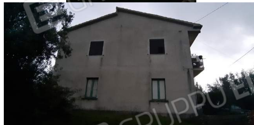
Foto n. 5 e 6: Prospetto Nord del fabbricato
