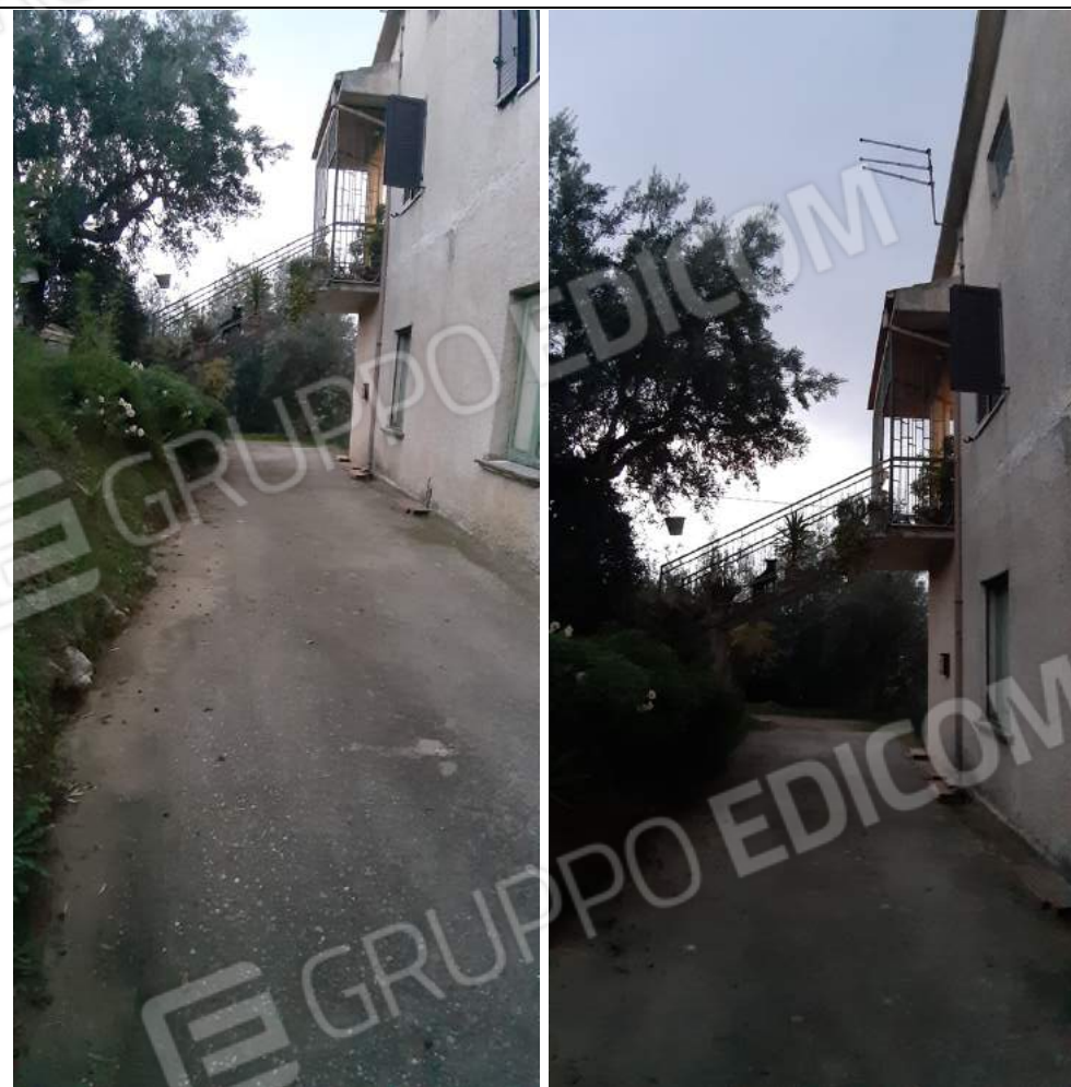
Foto n. 8 e 9: Vista da est della scala esterna sul prospetto sud
