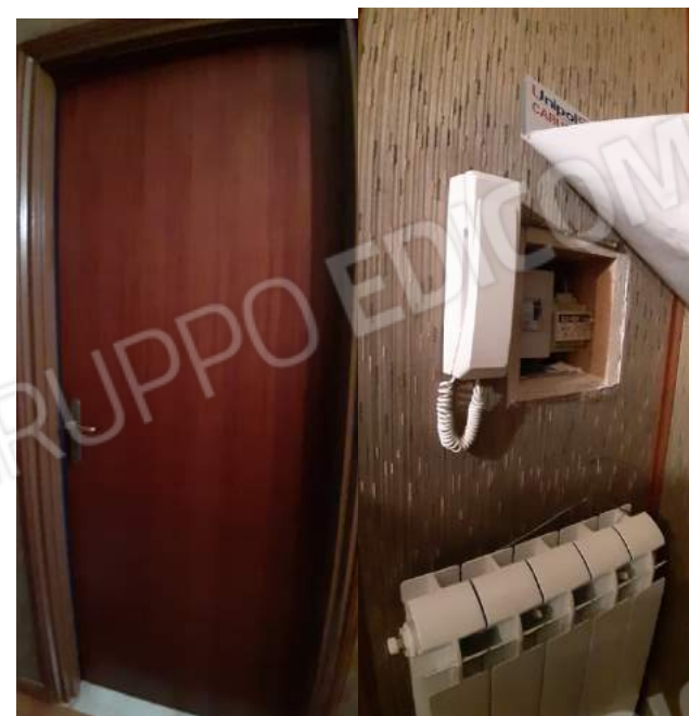
Foto n. 46, e n. 47: Particolari porta interna e componenti impianti
