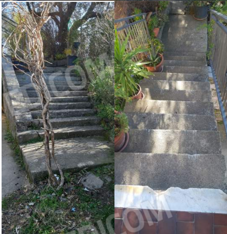
Foto n. 1 , n. 2 e n. 3: Scala esterna per l'accesso all'immobile
