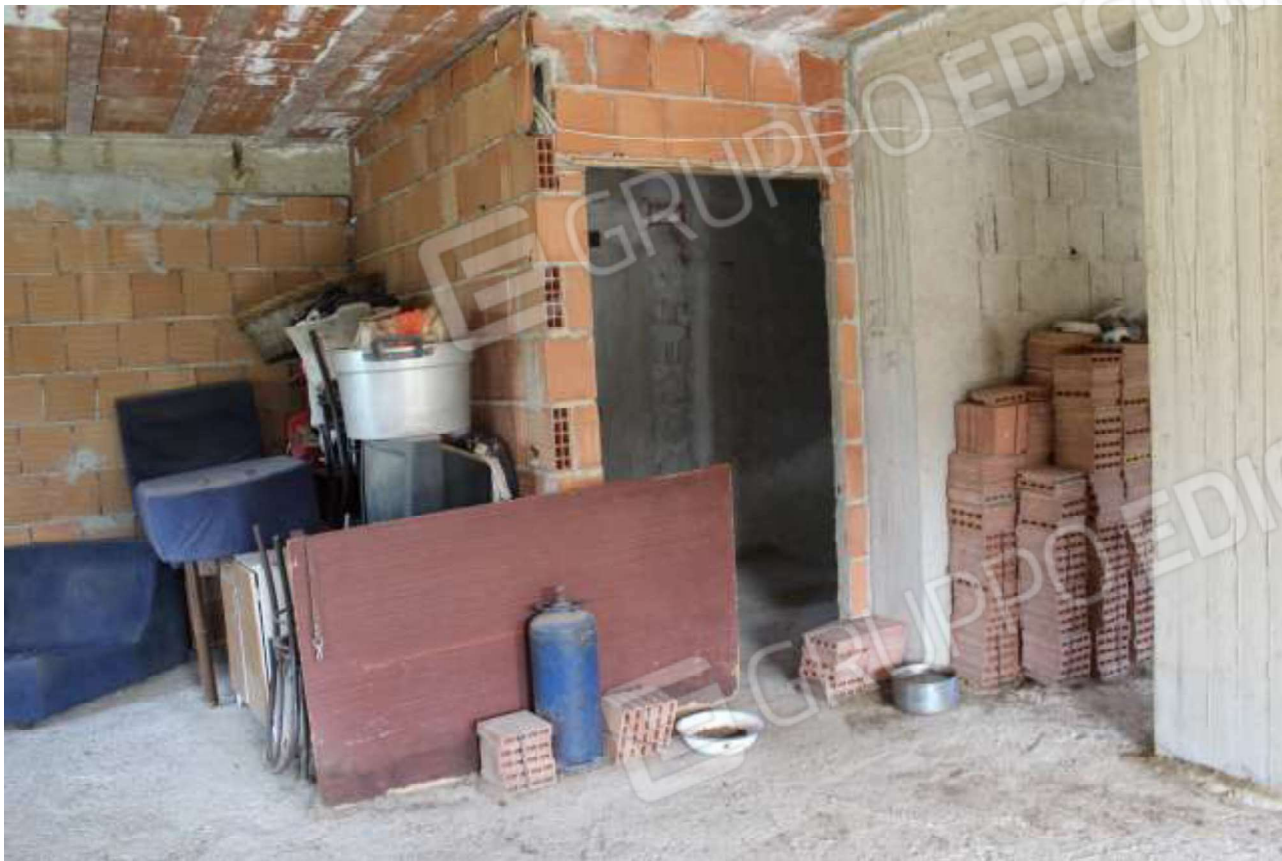
vista stato piano primo
