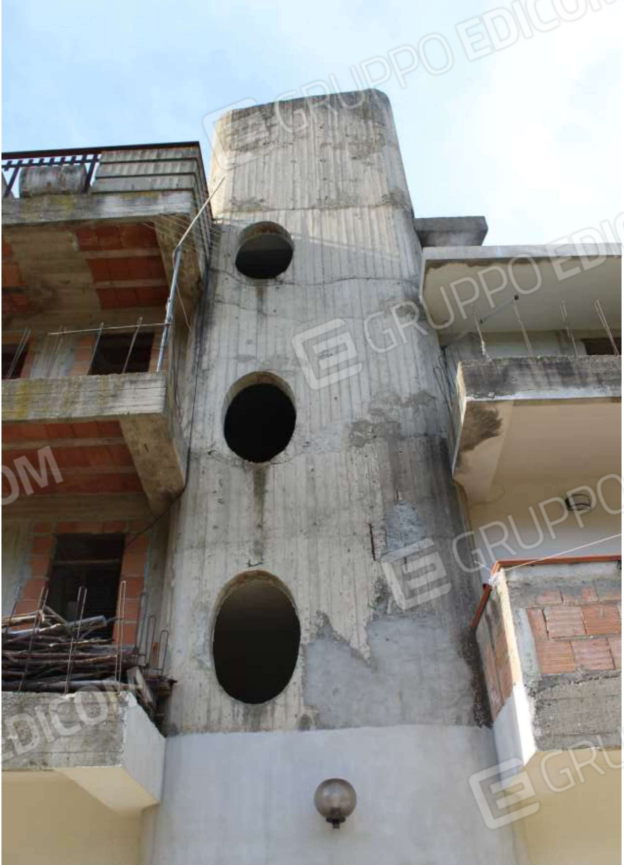
vista corpo scala
