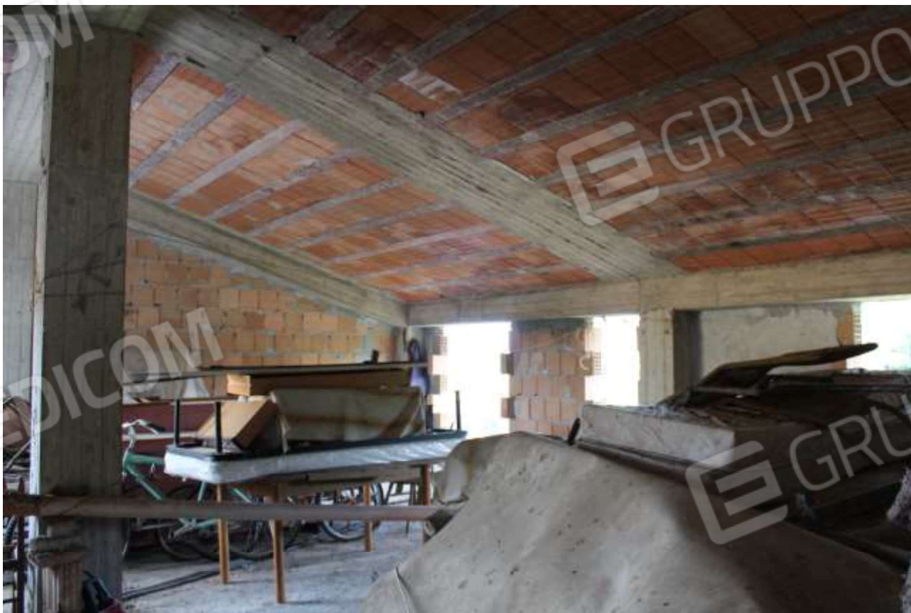
vista stato piano primo
