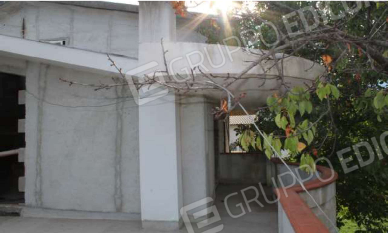
vista stato piano primo
