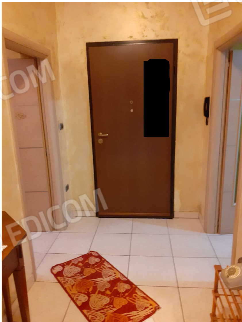
Foto 2 Portone di Ingresso vista interna
