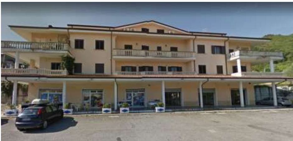
foto 1 – Vista prospettica fabbricato
