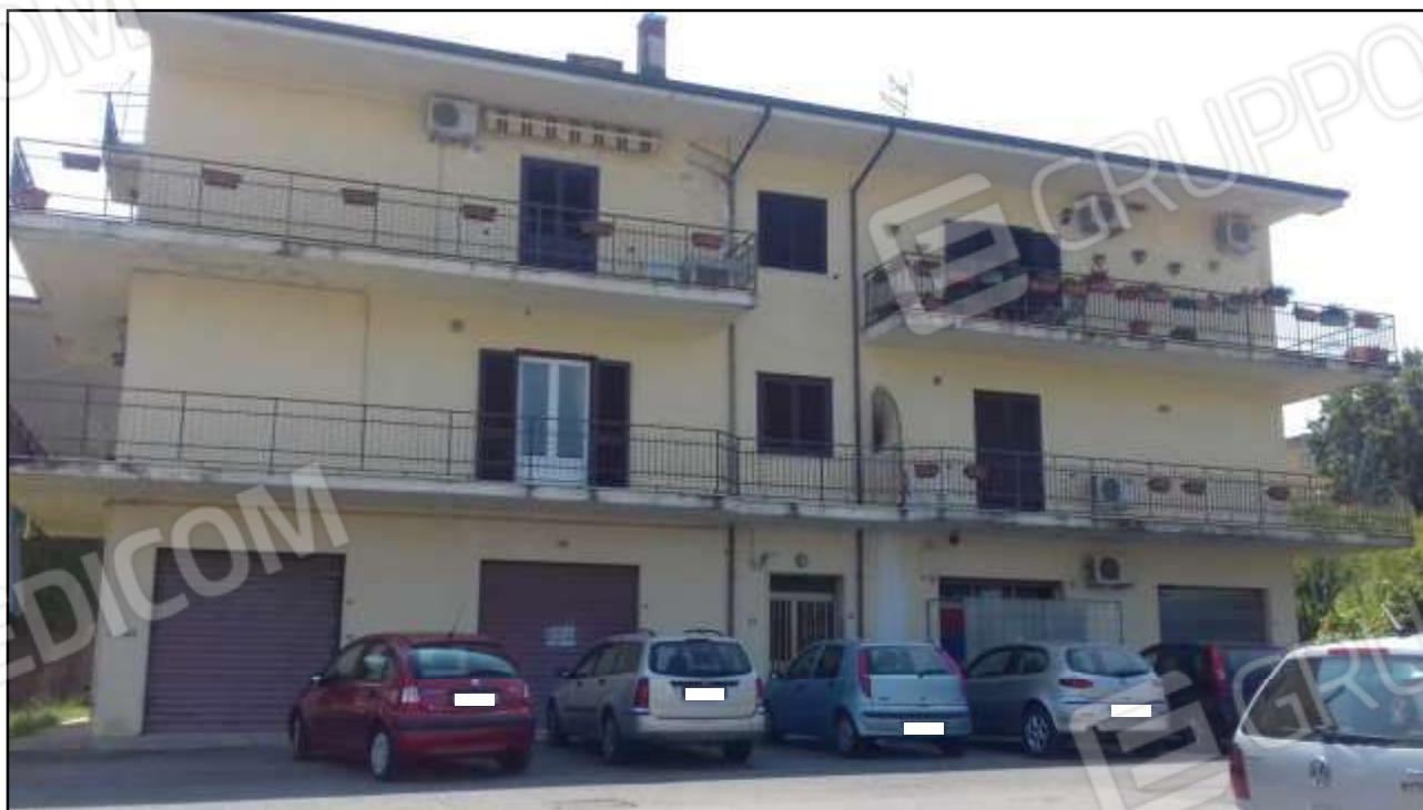
Fig. 2. - Fabbricato ubicato in Montalto Uffugo (CS), Via Aldo Moro, in cui sono ubicati i tre immobili oggetto della procedura esecutiva.
