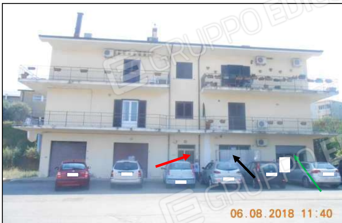
Fig. 1 – Fabbricato ubicato in Montalto Uffugo (CS), Via Aldo Moro, in cui sono ubicati i tre immobili oggetto della procedura esecutiva. INGRESSO DEL FABBRICATO IN CUI AL PIANO TERZO SI TROVA L'IMMOBILE CENSITO CON IL SUB 10 , SUB 14 E SUB 15 .
