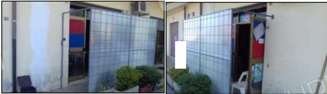
Fig. 6 – Ingresso del magazzino censito con il subalterno 14.
