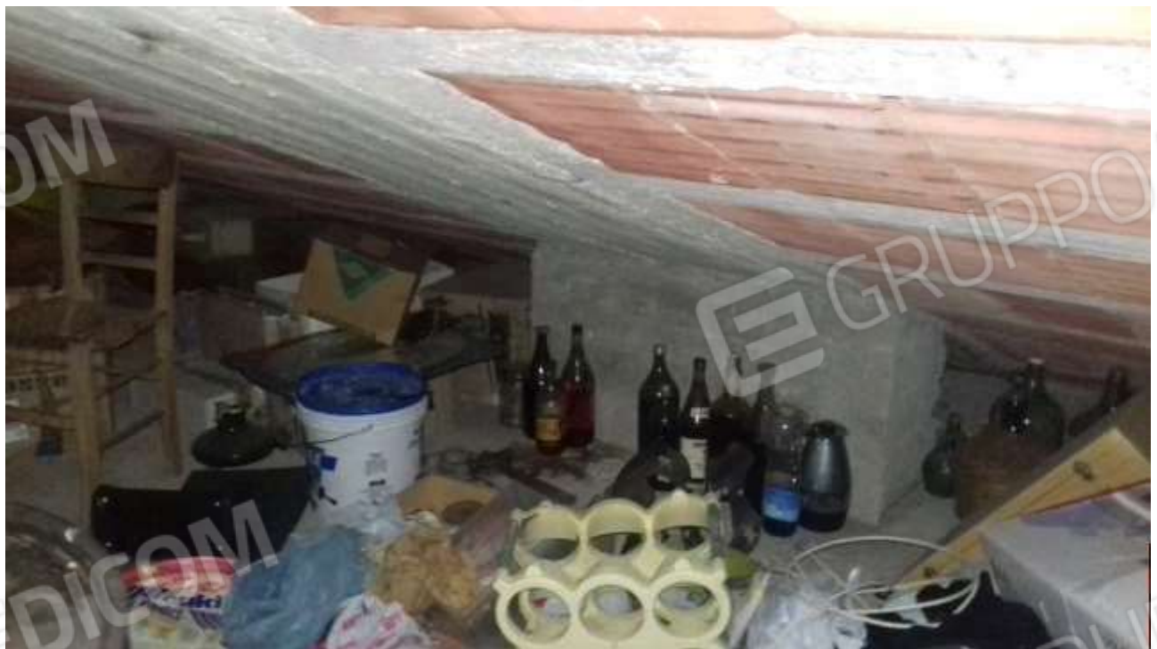
Fig. 10 – SUBALTERNO 10 : sottotetto non abitabile ed allo stato grezzo .
