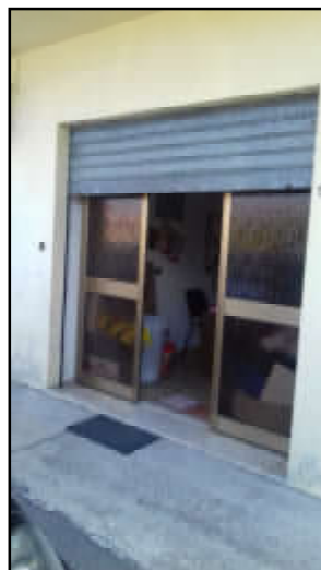
Fig. 6a – Ingresso del magazzino censito con il subalterno 15.
