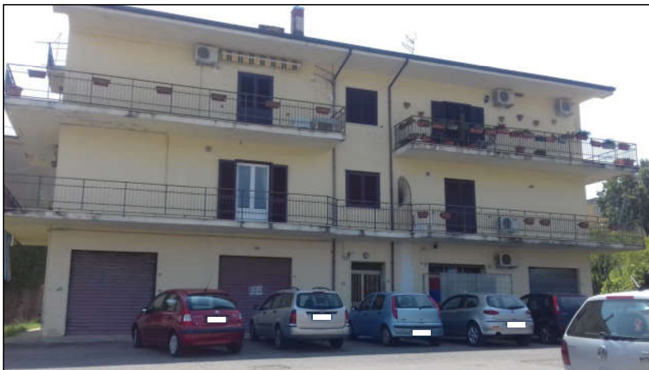
Fig. 2. - Fabbricato ubicato in Montalto Uffugo (CS), Via Aldo Moro, in cui sono ubicati i tre immobili oggetto della procedura esecutiva.
