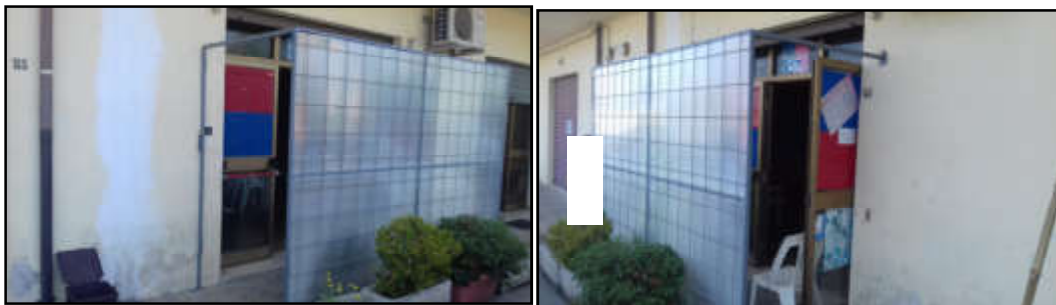
Fig. 6 – Ingresso del magazzino censito con il subalterno 14.
