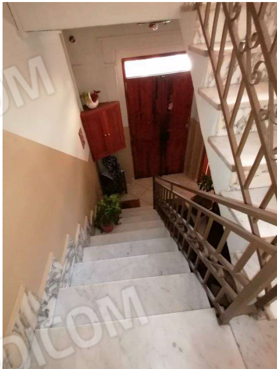
Vista vano scala
