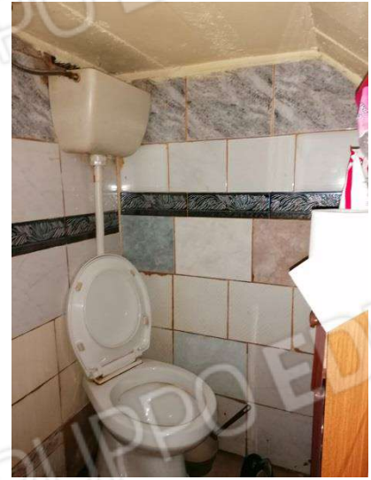
Bagno (piano terra)
