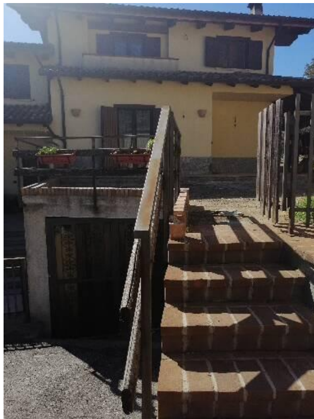
Fotografia 21 – Scala di accesso all'unità abitativa
