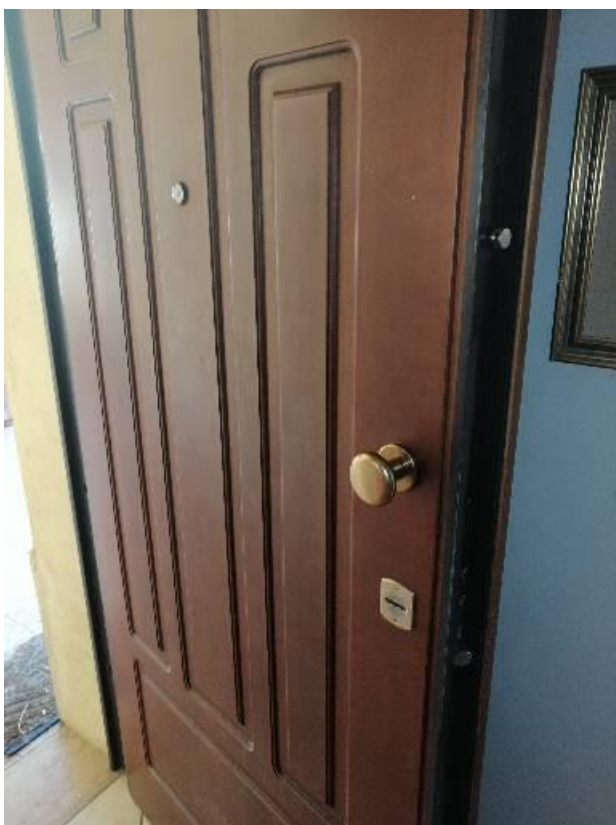
Fotografia 16 – Portone di ingresso principale
