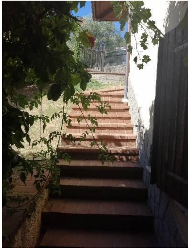
Fotografia 10 – Scala esterna di collegamento
