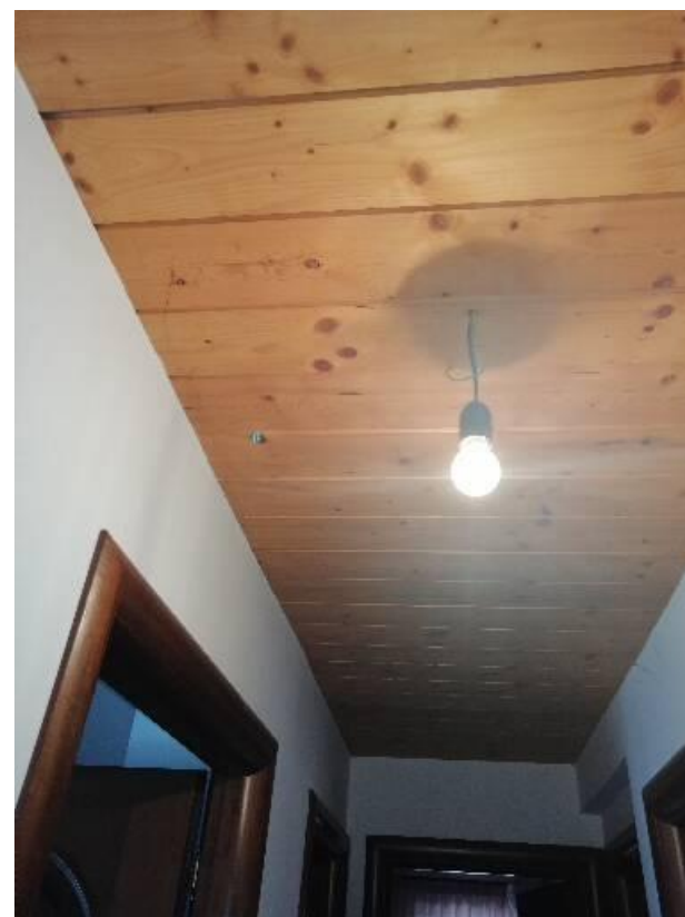
Fotografia 27 – Disimpegno (particolare soffitto con perlinato)
