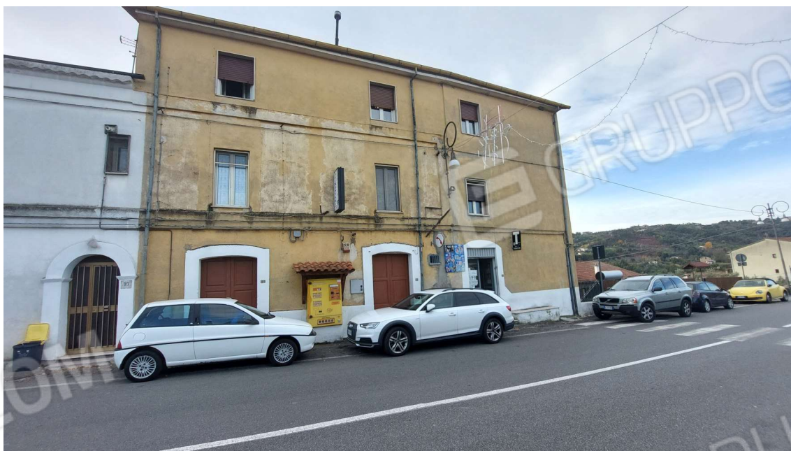
Foto n.2: Vista generale esterna
