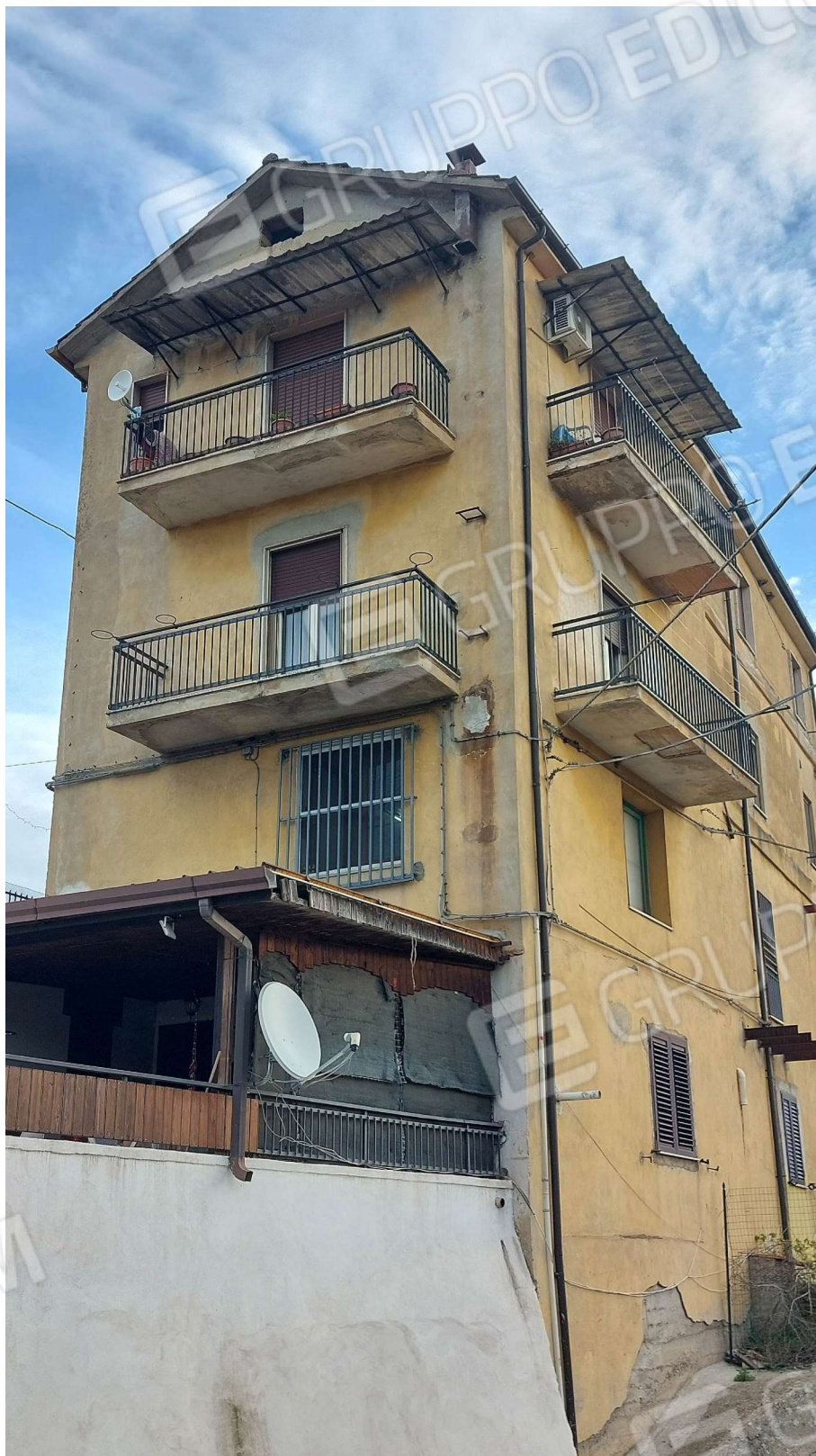
Foto n.3: Vista generale esterna
