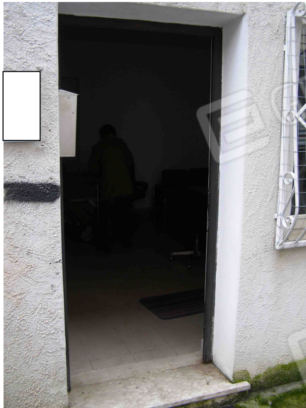
FOTO N° 2 : Ingresso unità immobiliare.
