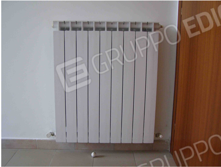
FOTO N° 29: Particolari impianto termico : radiatore in alluminio
