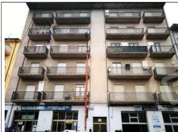
Figura 1 Vista frontale Palazzina Via panoramica 182
