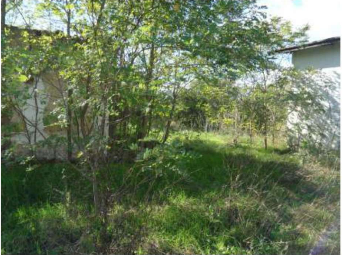
BENE N° 1 – FABBRICATO OBSOLETO (UNITA' COLLABENTE)
