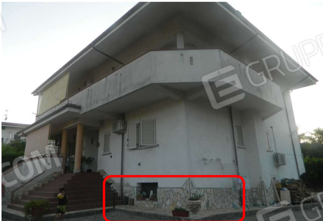
Vista esterna porzione di seminterrato annesso alla P.la 493 sub 7 (accessibile solo attraverso la p.la 493 sub 1 oggetto di pignoramento)
